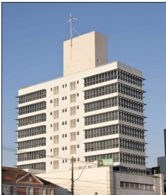
Figura 6 – TEPP em topo de prédio
