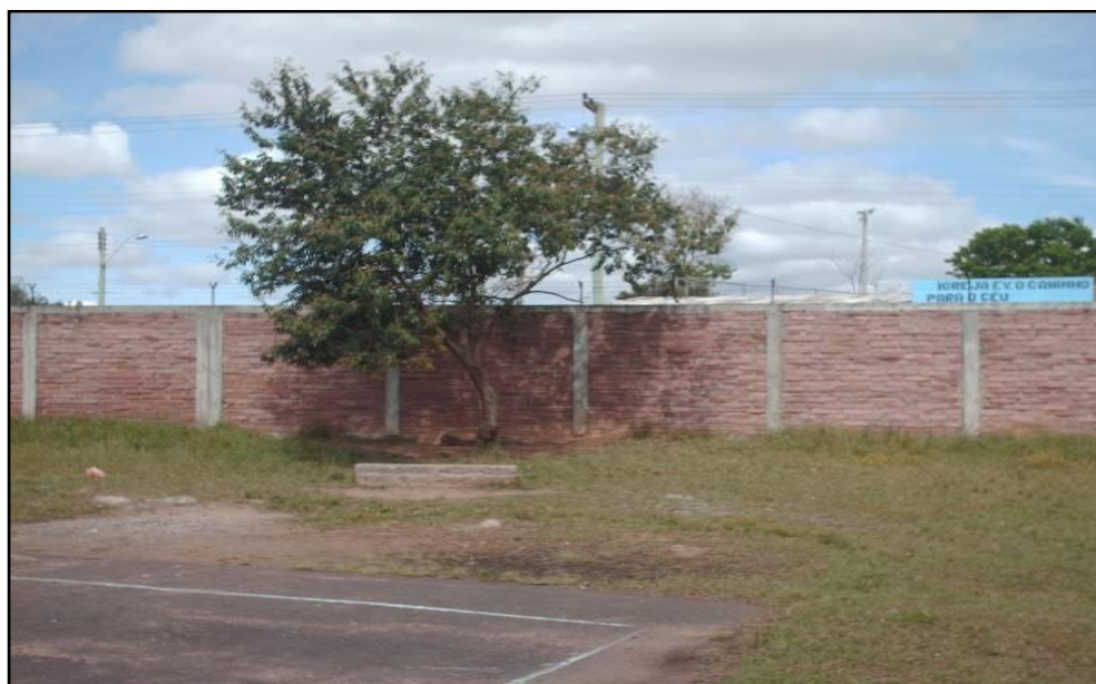
Figura 31: Um pedaço de concreto, um banco afastado.
