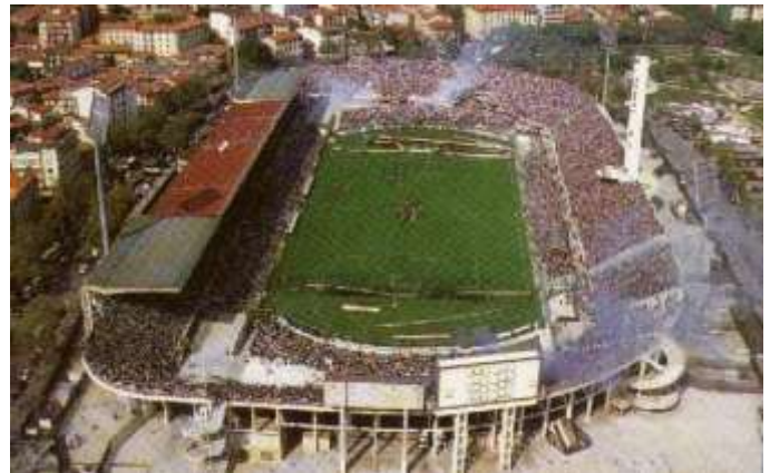
Figura 124: Vista aérea do Estádio de Firenze, 1929. Arquiteto: Luigi Nervi. Fonte: CAMPANINI, 1950
