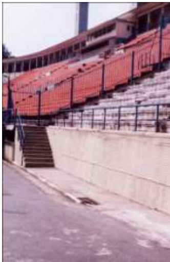
Figura 318: Circulação e acesso para arquibancadas. Fonte: Autor, 2002.
