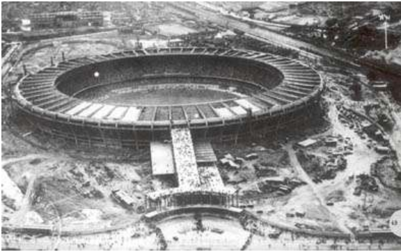
Figura 85: Foto da construção do Estádio Maracanã. Fonte: VIEIRA, 2000.
