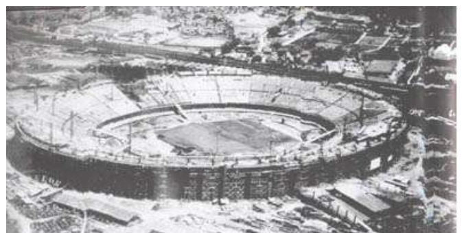
Figura 90: Foto da construção do Estádio Maracanã. Fonte: VIEIRA, 2000.
