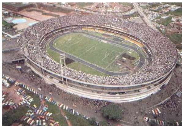
Figura 103: Vista aérea do Estádio do Morumbi, São Paulo/SP. Fonte: www.templsdofutebol.hpg.ig.com.br
