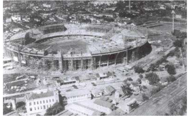
Figura 92: Foto da construção do Estádio Maracanã. Fonte: VIEIRA, 2000.
