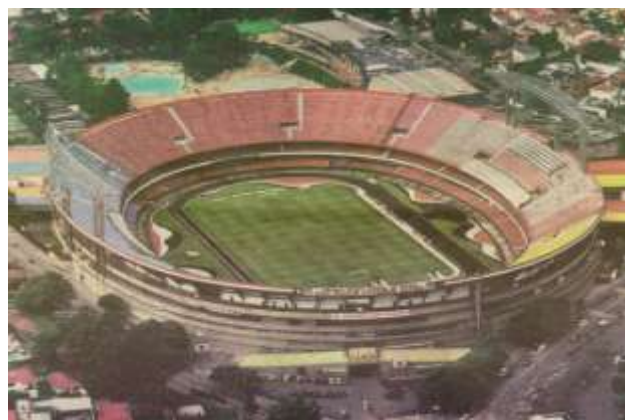
Figura 104: Vista aérea do Estádio do Morumbi, São Paulo/SP Fonte: www.templsdofutebol.hpg.ig.com.br
