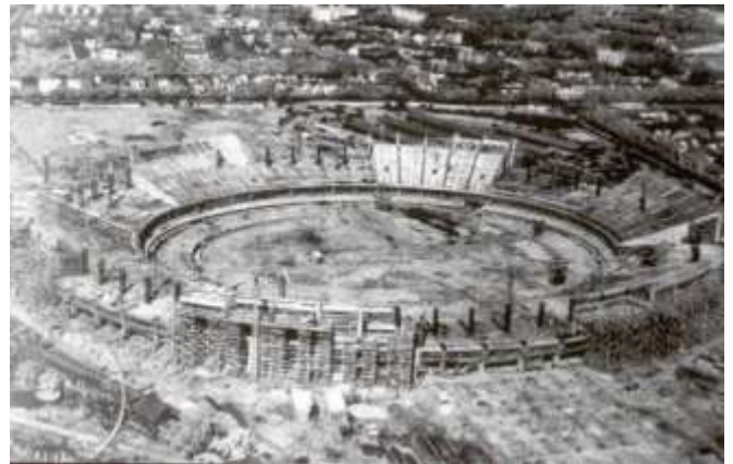
Figura 88: Foto da construção do Estádio Maracanã. Fonte: VIEIRA, 2000.
