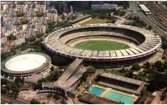
Figura 16: Vista aérea do complexo do Maracanã. Fonte: www.worldstadiums.com
