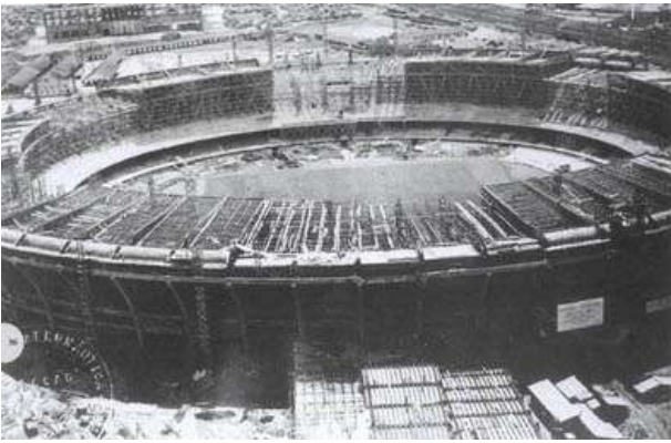
Figura 91: Foto da construção do Estádio Maracanã. Fonte: VIEIRA, 2000.
