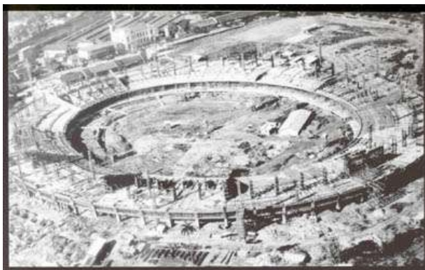
Figura 89: Foto da construção do Estádio Maracanã. Fonte: VIEIRA, 2000.
