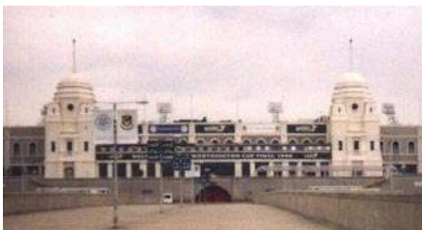
Figura 397: Vista do acesso das duas torres do Estádio Olímpico de Wembley, 1923. Arquiteto: Sir John Simpson e Maxwell Ayerton. Fonte: CAMPANINI, 1950
