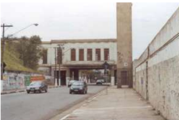
Figura 313: Detalhe salão de imprensa. Fonte: Autor, 2002.
