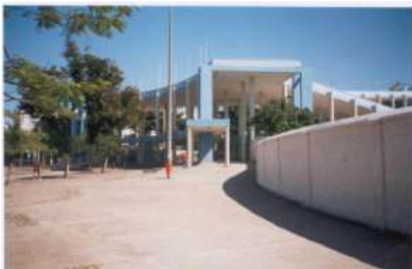
Figura 336: Detalhe do pórtico de acesso. Fonte: Autor, 2002.
