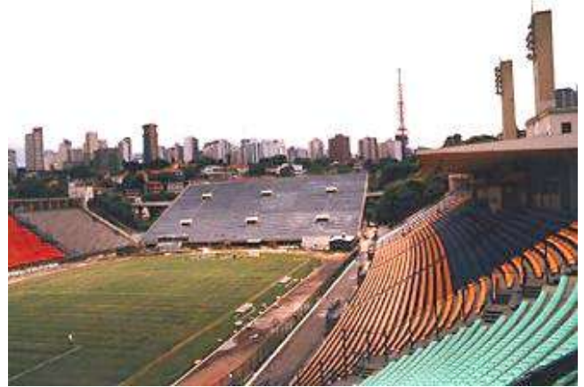
Figura 68: Vista interna do Estádio Pacaembu, São Paulo/SP. Fonte: www.templosdofutebol.hpg.ig.com.br
