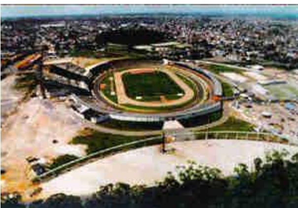
Figura 193: Estádio Centro Esportivo Pinheirão, Curitiba/PR. Fonte: worldstadiums.com
