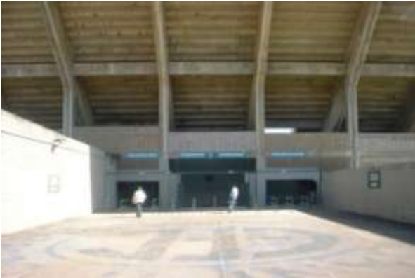
Figura 357: Vista rampa de acesso. Fonte: Autor, 2002.
