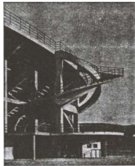
Figura 132: Detalhe da circulação vertical do Estádio de Firenze, 1929. Arquiteto: Luigi Nervi. Fonte: CAMPANINI, 1950
