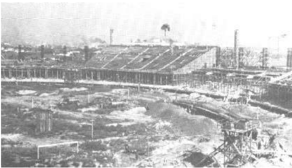
Figura 324: Foto da construção. Fonte: VIEIRA, 2000.
