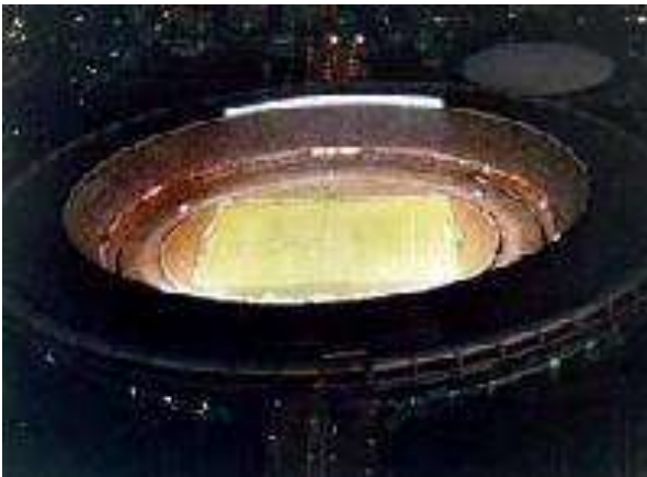
Figura 333: Vista aérea noturna do estádio. Fonte: www.templodofutebol.hpg.ig.com.br
