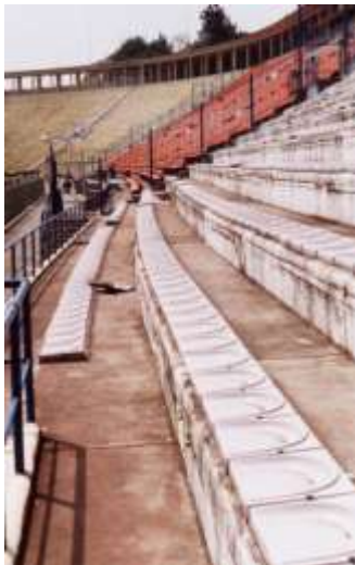
Figura 319: Assentos numerados instalados nas arquibancadas. Fonte: Autor, 2002.
