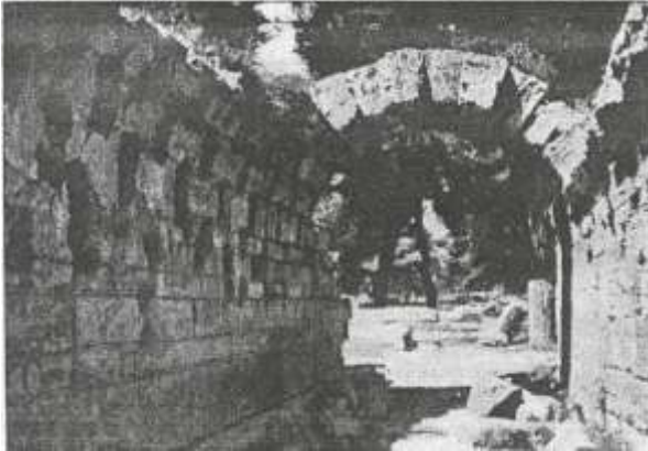
Figura 22: Ruínas do túnel de acesso ao Estádio de Olímpia, Grécia Fonte: CAMPANINI, 1950
