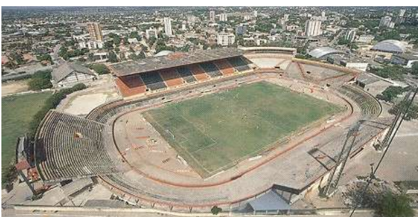
Figura 214: Estádio da Ilha do Retiro, Recife/PE. Fonte: www.temposdofutebol.hpg.ig.com.br
