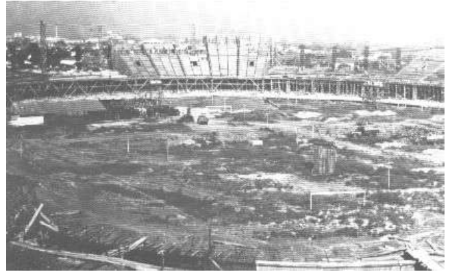
Figura 86: Foto da construção do Estádio Maracanã. Fonte: VIEIRA, 2000.
