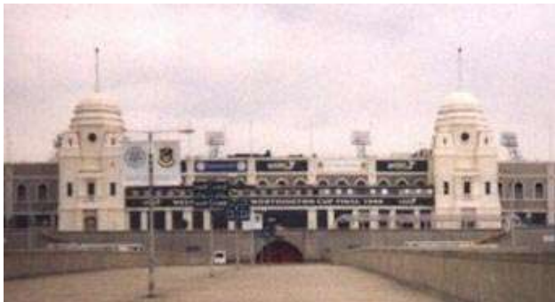
Figura 118: Vista do acesso das duas torres do Estádio Olímpico de Wembley, 1923. Arquiteto: Sir John Simpson e Maxwell Ayerton. Fonte: CAMPANINI, 1950
