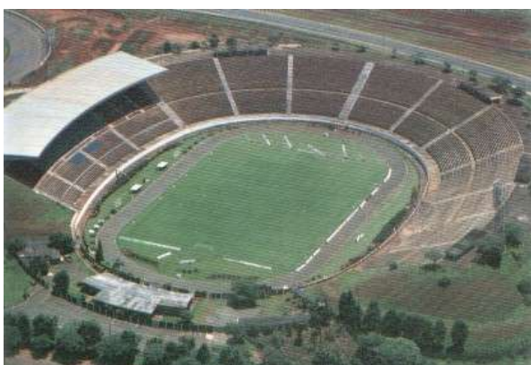
Figura 359: Vista aérea do estádio. Fonte: www.temposdofutebol.hpg.ig.com.br
