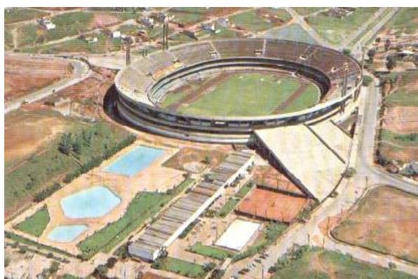
Figura 105: Vista aérea do Estádio do Morumbi, São Paulo/SP. Fonte: www.templsdofutebol.hpg.ig.com.br
