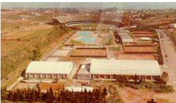
Figura 352: Foto da construção. Fonte: VIEIRA, 2000.
