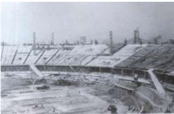
Figura 87: Foto da construção do Estádio Maracanã. Fonte: VIEIRA, 2000.
