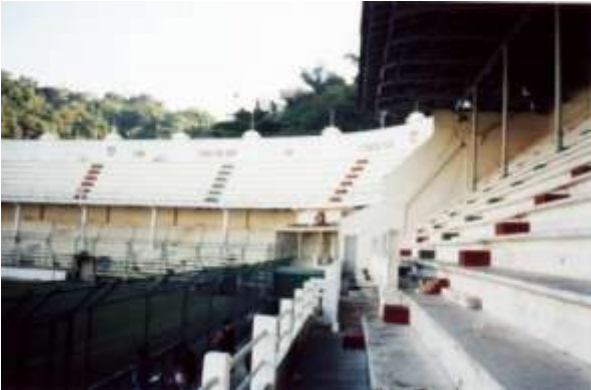
Figura 223: Estádio das Laranjeiras, Rio de Janeiro/RJ. Fonte: Autor, 2002.
