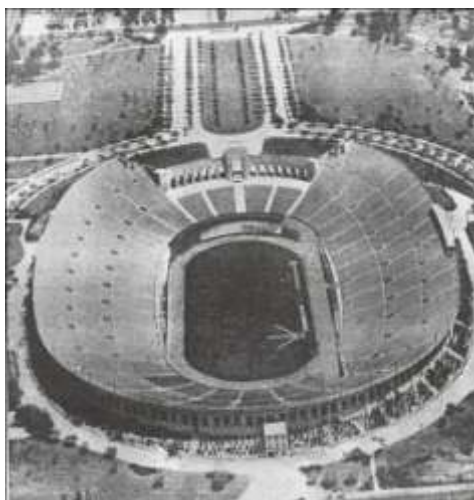
Figura 82: Processo de escavação, construção e movimentação de terra. Estádio Olímpico de Los Angeles, Estados Unidos. Arquiteto: ***** Fonte: CAMPANINI, 1950
