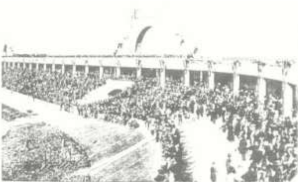
Figura 107: Vista interna do Estádio de Lyon, França, 1913. Arquiteto Tony Garnier Fonte: BADOVICI,xxxx.
