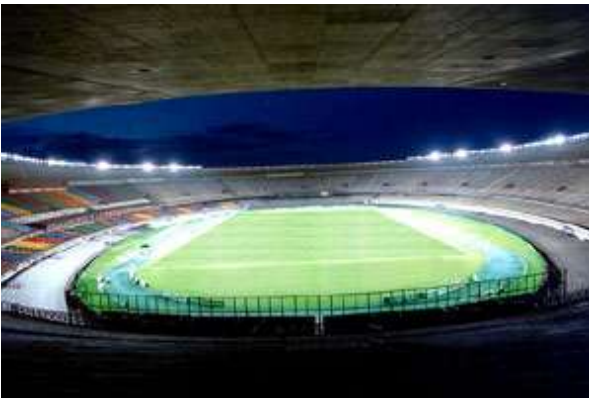
Figura 367: Vista geral interna. Fonte: www.templosdofutebol.hpg.ig.com.br
