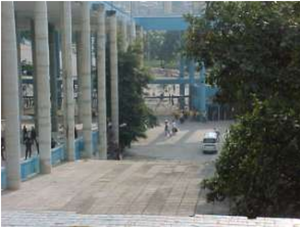
Figura 335: Detalhe do acesso às rampas. Fonte: Arquivo Joaquim Esteves.
