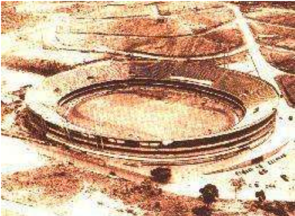
Figura 351: Foto da construção. Fonte: VIEIRA, 2000.
