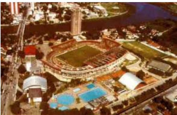
Figura 35: Estádio da Ilha do Retiro, Recife/PE. Fonte: www.temposdofutebol.hpg.ig.com.br
