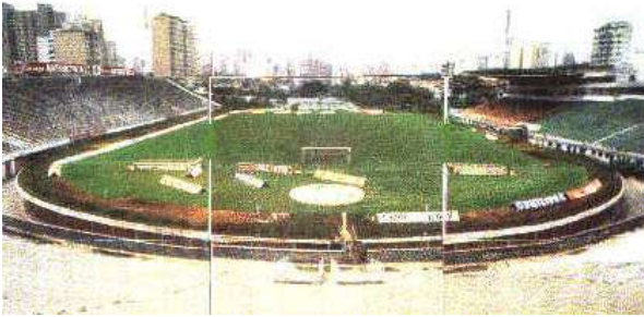
Figura 305: Vista interna. Fonte: www.worldstadiums.com
