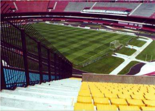
Figura 356: Vista interna do anel superior de arquibancadas. Fonte: Autor, 2002.
