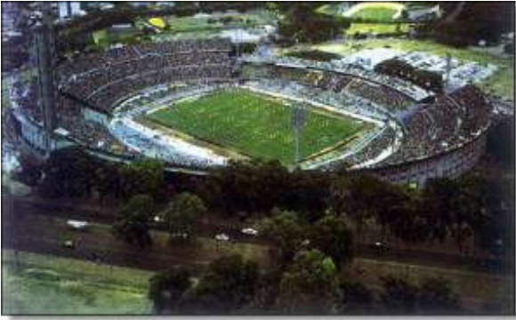
Figura 378: Estádio Centenário, Montevidéu. Fonte: www.worldstadiums.com
