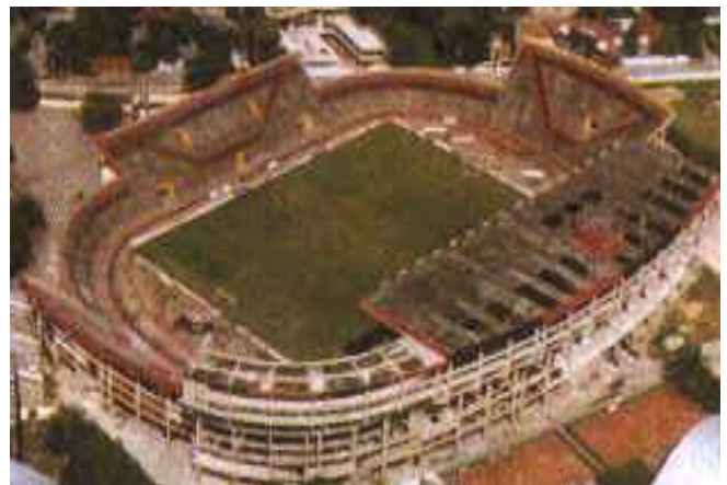
Figura 36: Estádio da Ilha do Retiro, Recife/PE. Fonte: www.temposdofutebol.hpg.ig.com.br
