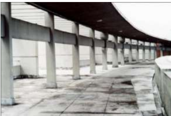
Figura 374: Vista do pergolado sobre as arquibancadas. Fonte: Autor, 2001.
