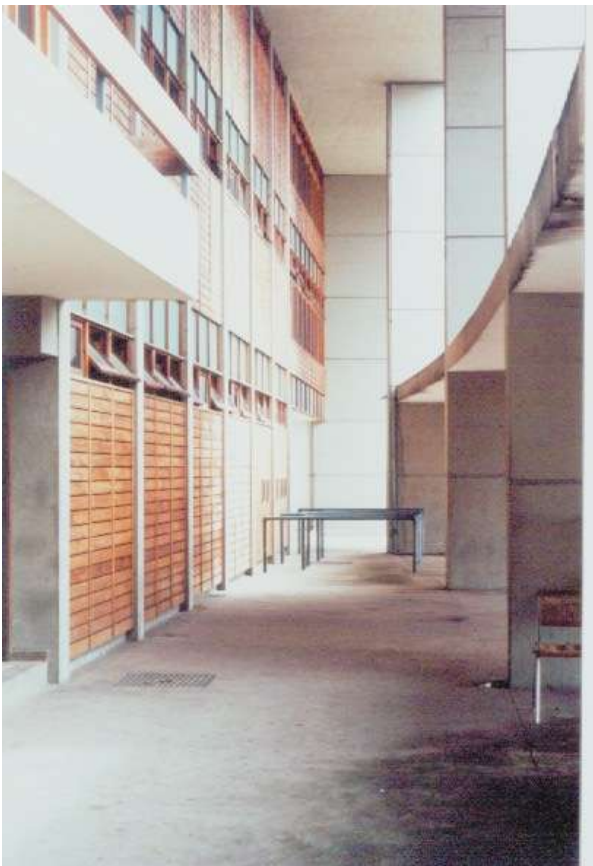
Figura 372: Contraste entre concreto e madeira marcam o setor administrativo. Fonte: Autor, 2001.
