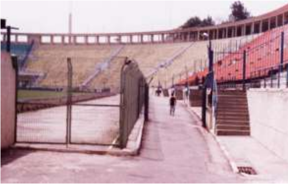
Figura 317: Circulação e acesso para arquibancadas. Fonte: Autor, 2002.
