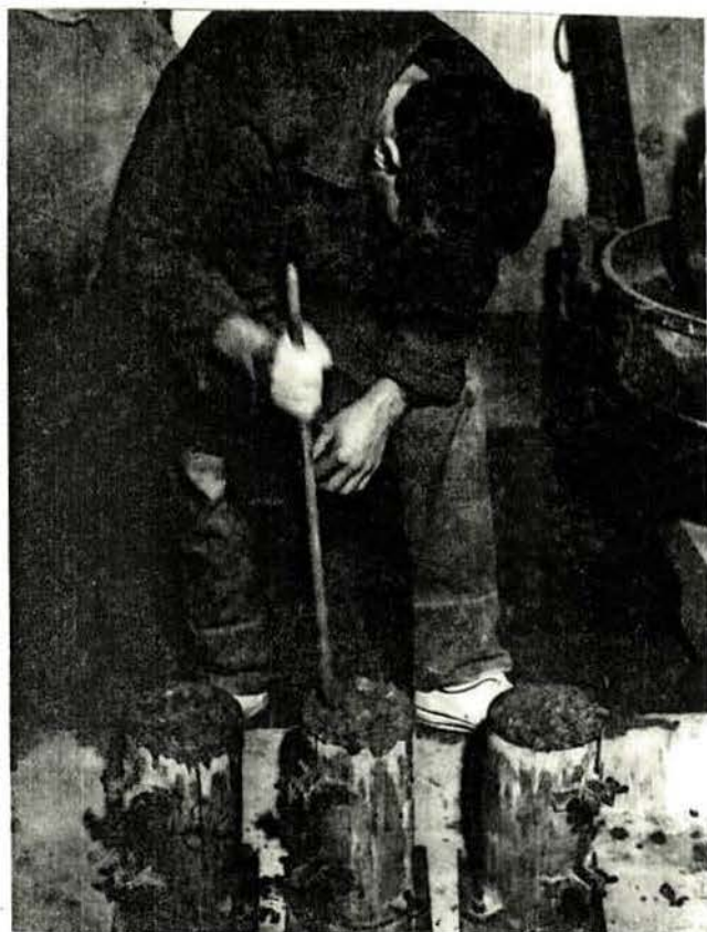
FIGURA 5.10. Confeção dos CP cilíndricos destinados ao controle da resistência do concreto.
