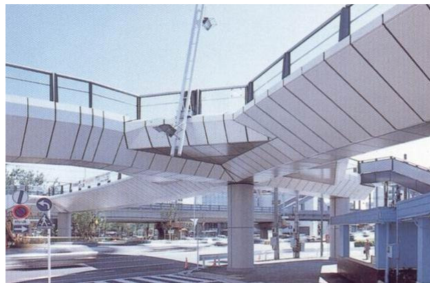
Figura 3.13: fôrmas permanentes de GRC (GRCA, 1995)
