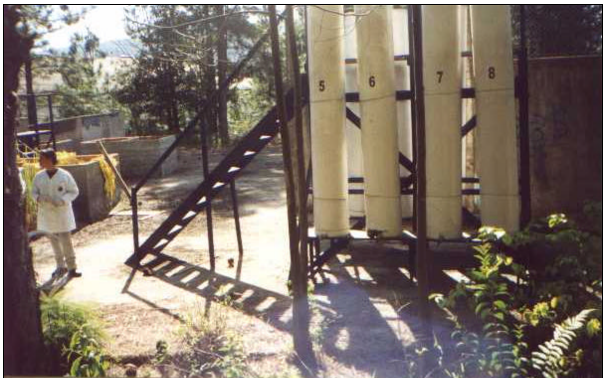
Figura 4.11 – Reatores após a conclusão da montagem
