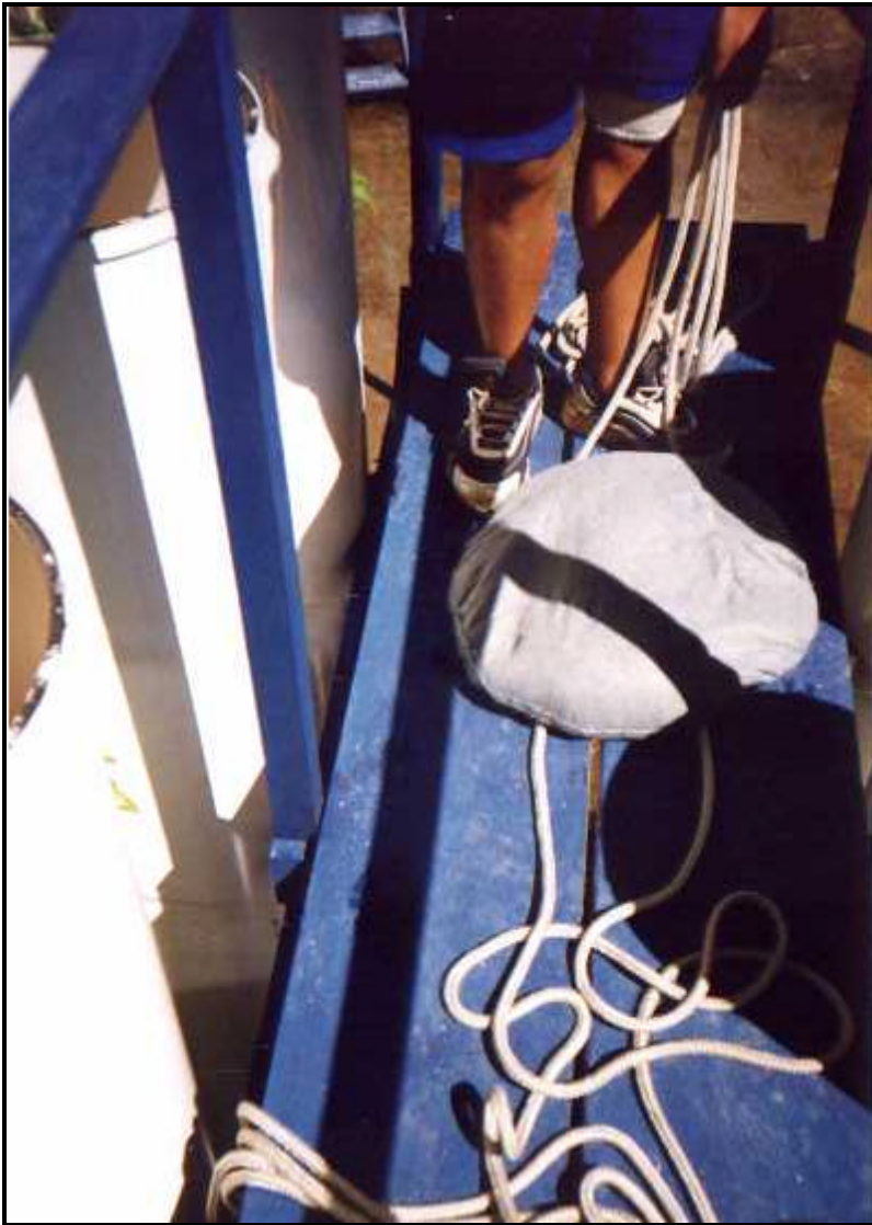
Figura 4.9 – Colocação da almofada de areia no interior do reator
