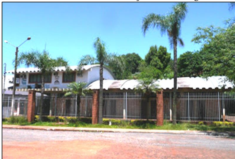
Figura 65 – Sede da Feira do Produtor de Ijuí e sede da Regional da Emater
