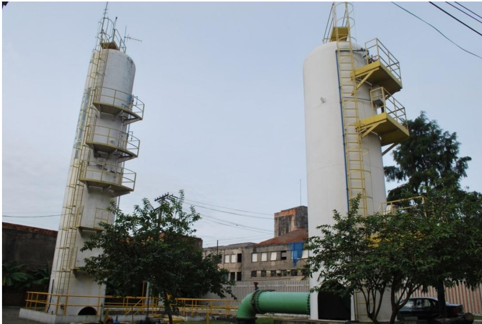
Figura 3.7. Reservatórios Hidropneumáticos.
