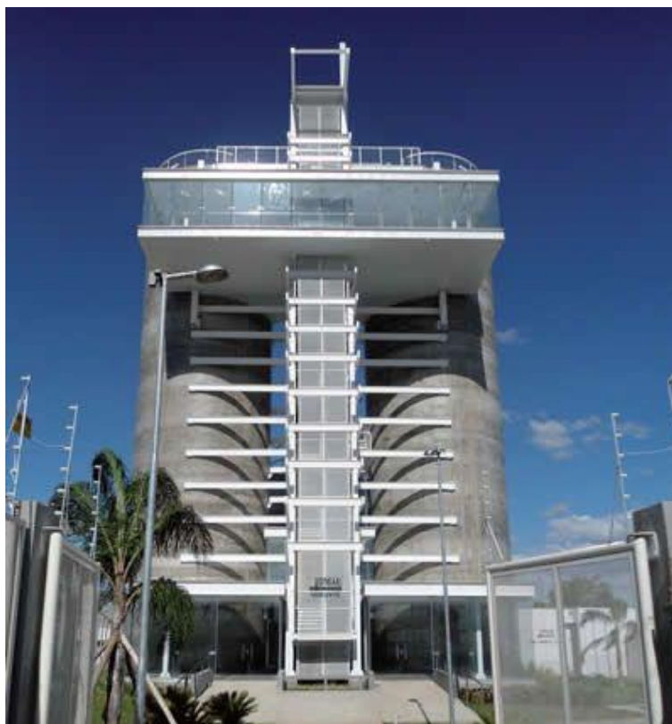
Figura 3.4. Chaminés de Equilíbrio do Sistema de Bombeamento de Esgoto Cloacal Cristal (DMAE/Porto Alegre). Fonte: Revista Infraestrutura Urbana, 2014, p. 31.
