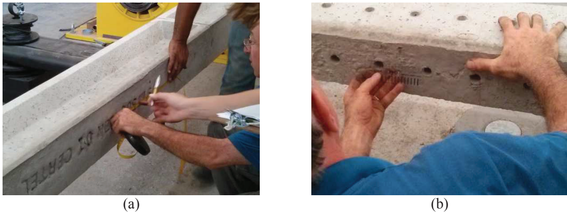
Figura 28: (a) Determinação da posição da fissura (b) e tamanho da abertura da fissura.
