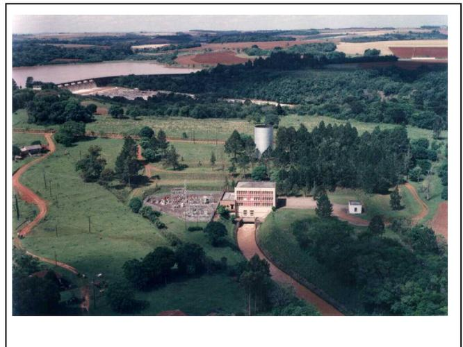
A usina tem uma barragem em concreto protendido de 14,32 m de altura, com comprimento de 400 m e inunda uma área de 57,37 km<sup>2</sup>. A acumulação do reservatório é de 258,5 hectômetros cúbicos,
