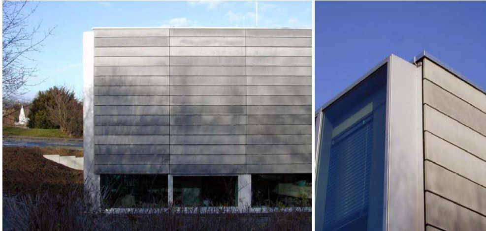
Figura 10– Elementos de fachada utilizando concreto têxtil
