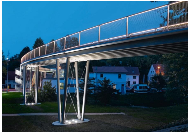
Figura 17 – Passarela de concreto têxtil e armado
