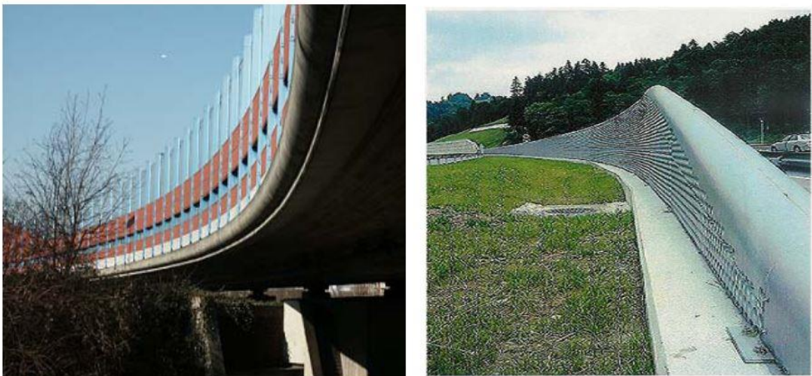
Figura 12 – Paredes para proteção acústica
