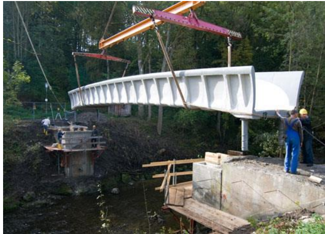
Figura 16 – Passarela de concreto têxtil
