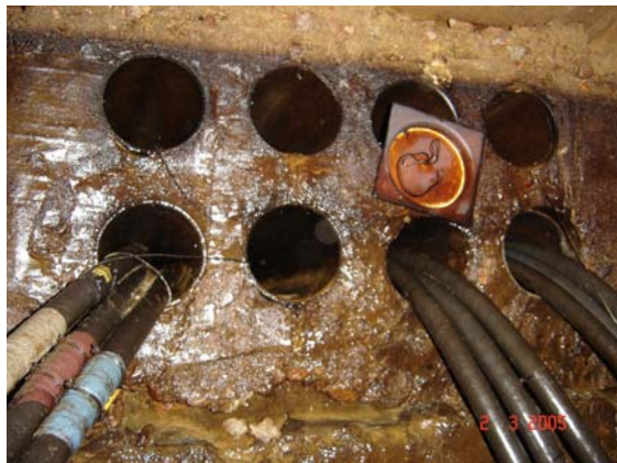
Figura 2: Construção de rede subterrânea através de banco de dutos.
