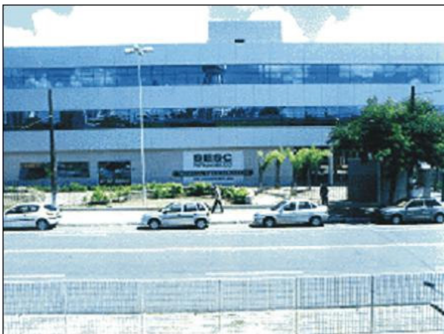
Figura 12 – Visão do Prédio da Administração Regional do SESC/PE
