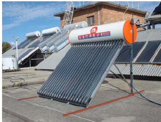
Figura 2.1 Coletor solar de tubos evacuados. Fonte: Morrison (2006).
