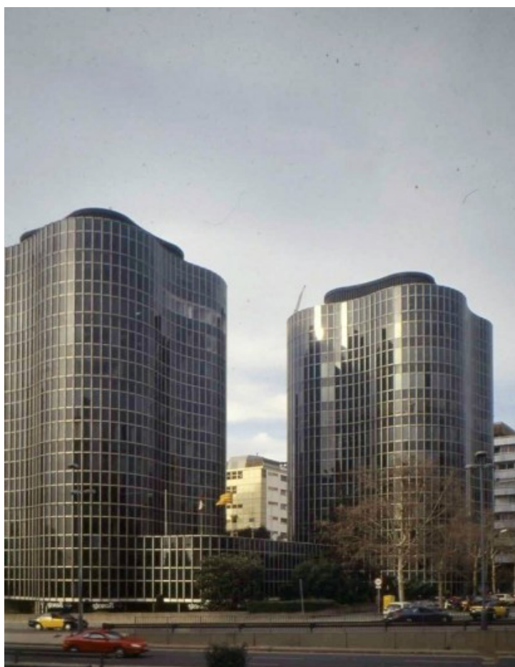
Figura 9 - José A. Coderch, Edifícios Trade, Barcelona, 1965. A sinuosidade do conjunto encobre o fato de que a planta das torres não é mais do que um quadrado cujos lados foram tratados como curvas côncavas e convexas
