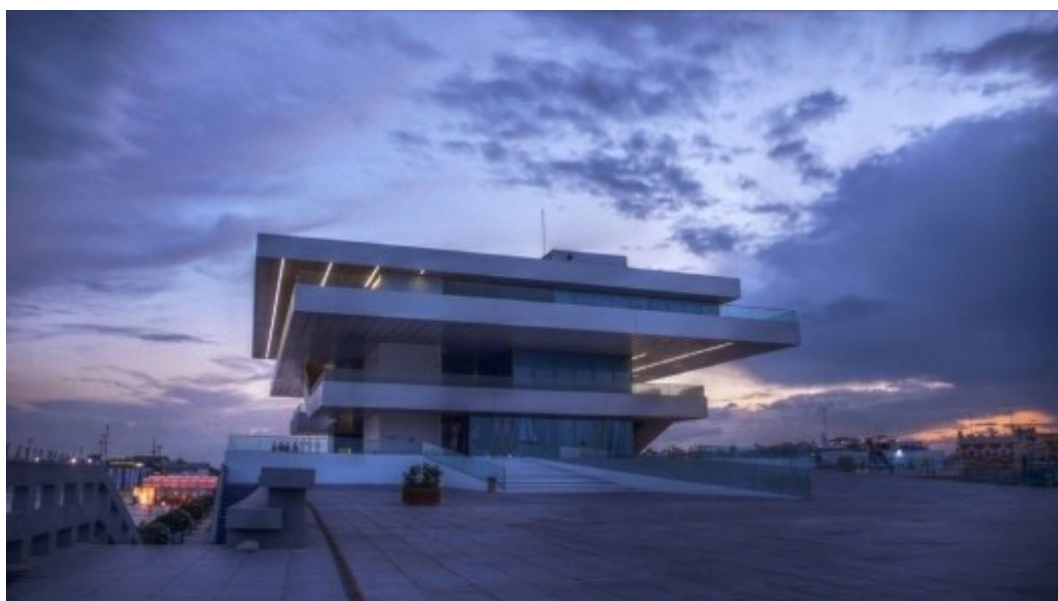
Figura 8 - David Chipperfield, Edifício Veles e Vents, Valencia, 2005. Sem ser um bloco compacto ou composição elementar ortodoxa possui estrutura formal muito clara
