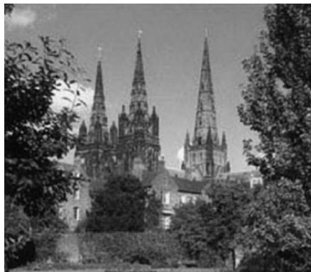
Figura 2.1 – Catedral de Litchfield em Staffordshire no Reino Unido (adaptada de Baker, 2007, p. 846)
