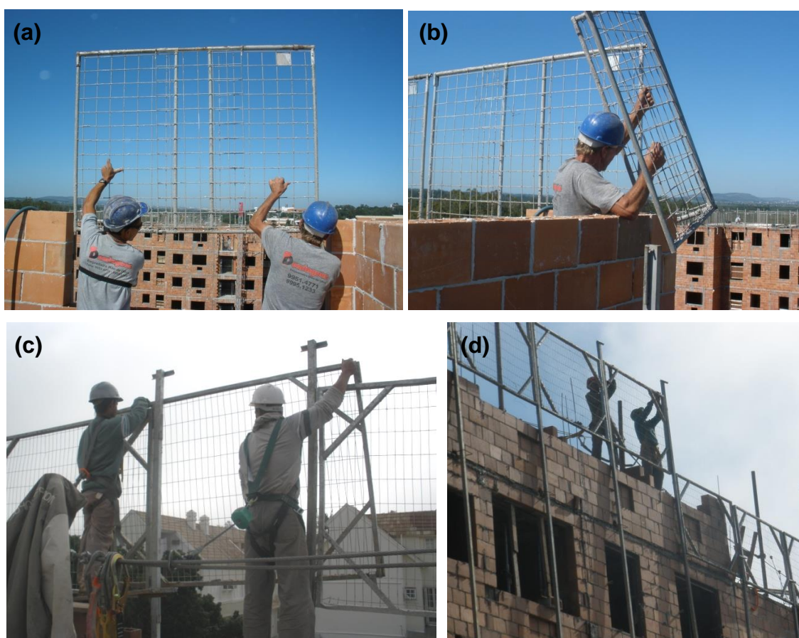
Figura 30. Postura de braço acima do ombro: (a), (b) encaixe das telas aos montantes do SPP ME-2; (c) desmontagem da tela do SPP ME-1; (d) encaixe da tela aos montantes do SPP ME-1.
