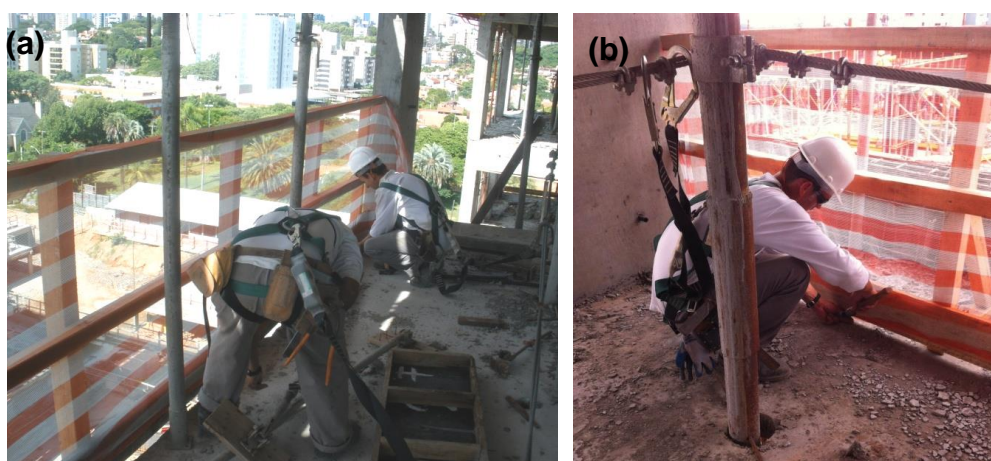
Figura 24. Posturas de pé, apoiado sobre os dois joelhos curvados, e costas curvadas: (a) fixação do componente rodapé do SPP-MA-1; (b) fixação da tela de proteção do SPP-MA-2.
