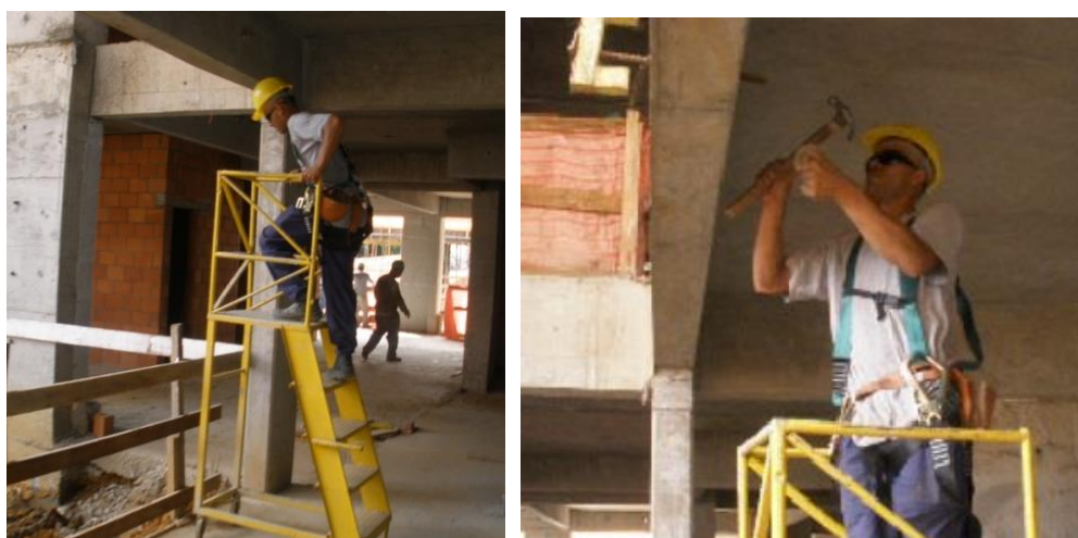
Figura 19. SPP-MI-5. Exemplo de atendimento ao requisito 5 na desmontagem.
