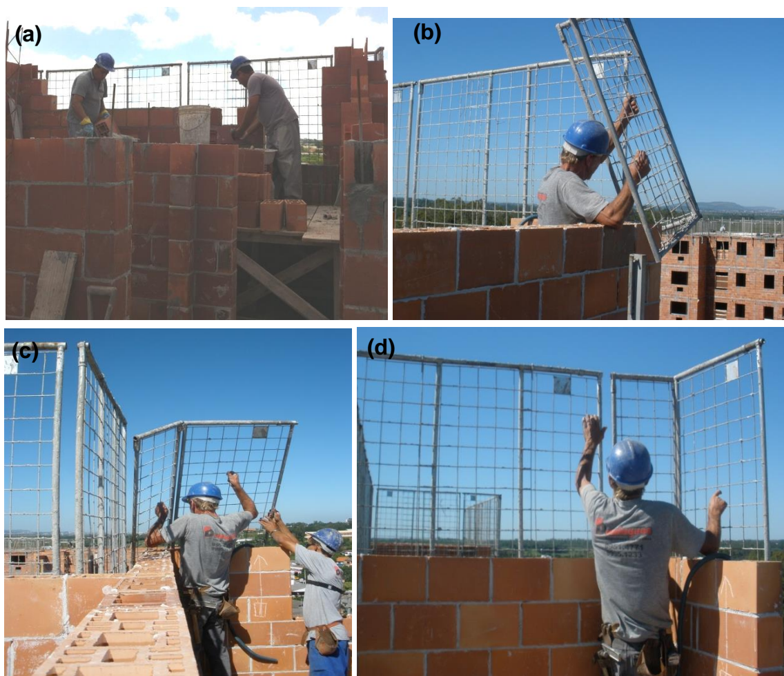
Figura 20. SPP-ME-2. Exemplo de atendimento ao requisito 5 na montagem e desmontagem.
