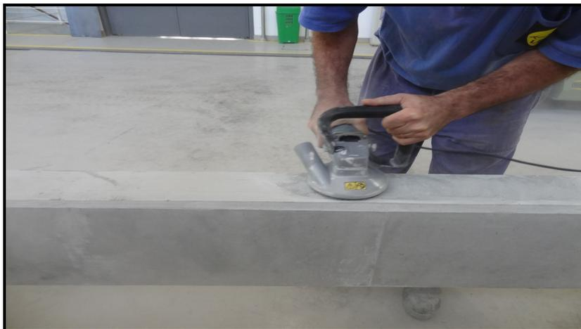
Figura 3.43 – Remoção da nata de concreto da face inferior da VRE1 com politriz
