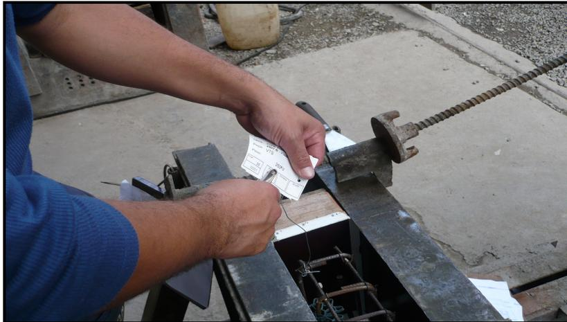
Figura 3.20 – Cubos de madeira para separação entre vigas dentro do extenso molde
