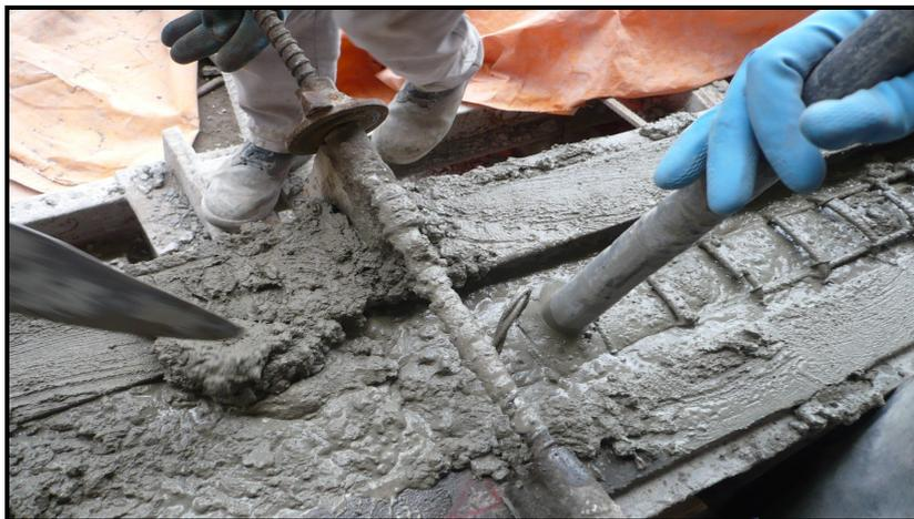
Figura 3.27 – Adensamento do concreto com vibrador elétrico
