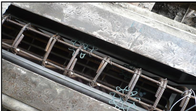
Figura 3.17 – Disposição das armaduras das VTS-1, VTS-2, VTS-3, VTS-4, VTS-5, VTS-6, VTS-7 e VTS-8
