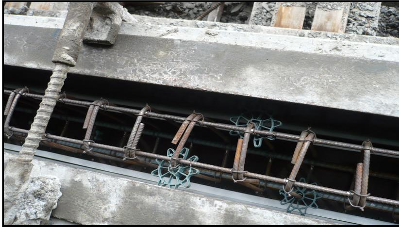
Figura 3.16 – Disposição das armaduras das VTP-1 e VTP-2
