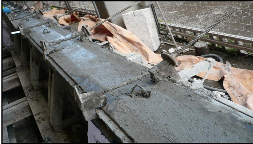
Figura 3.29 – Aspecto final da superfície exposta das vigas
