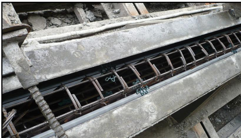
Figura 3.21 – Aspecto das superfícies internas dos moldes após aplicação de desmoldante
