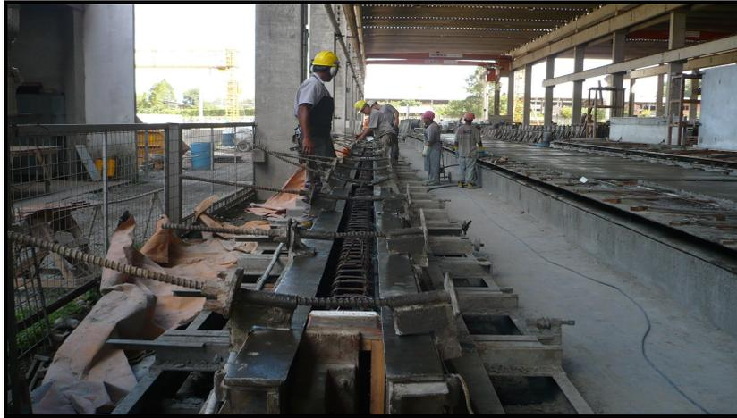
Figura 3.22 – Conferência do posicionamento de cada conjunto de armaduras para liberação de concretagem das vigas
