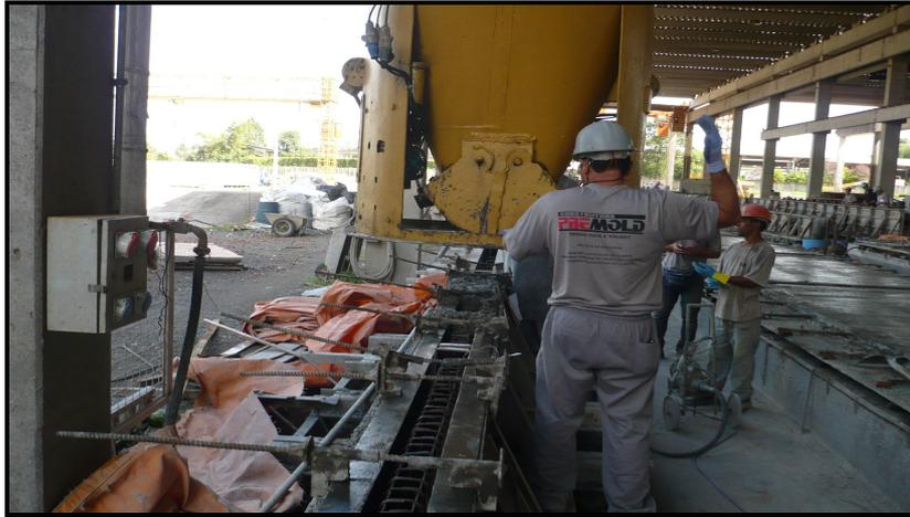
Figura 3.26 – Concretagem das vigas no segundo dia
