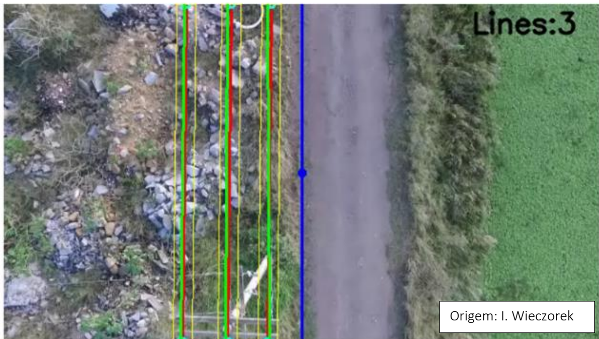
Figura 5 Detecção das linhas de alta tensão.
