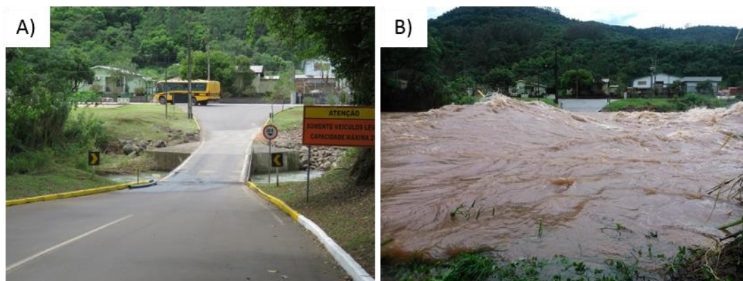
Figura 4 - Comparação. A) estado normal e B) inundação brusca no arroio Forromeco-RS.
