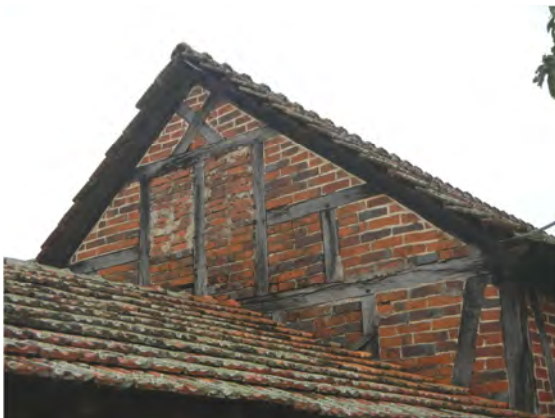
Imagem 91: Detalhe da estrutura enxaimel da propriedade da família Schiefelbein na Localidade Várzea do Agudo. Fonte: Fotografia do autor (2013).
