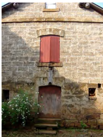
Imagem 115: Residência construída integralmente com pedras arenito aparelhadas e recobertas com fluido à base de cal e areia. Fonte: Fotografia do autor (2009).
