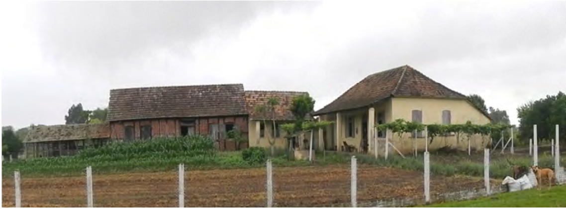
Imagem 63: Implantação da antiga residência rural da família Schiefelbein na Localidade Várzea do Agudo, próxima poucos quilômetros da sede. Fonte: Fotografia do autor (2013).
