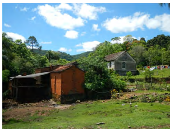
Imagem 195: Galpão (ou estufa) de secagem de fumo e residência em segundo plano no interior do município. Fonte: Fotografia do autor (2013).
