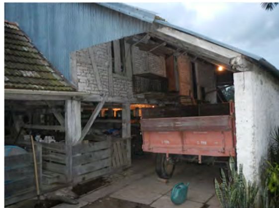
Imagem 86: Construção enxaimel transladada elevada para servir de depósito da propriedade Behrenz no Canto Católico. Fonte: Fotografia do autor (2013).
