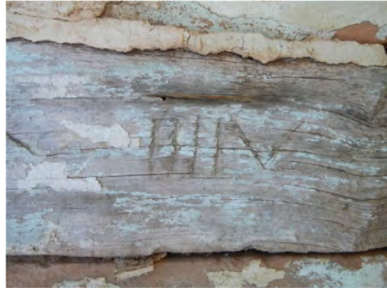
Imagem 88: Detalhe da estrutura enxaimel do Salão de baile e Armazém Müller na Localidade Linha Boêmia. Fonte: Fotografia do autor (2013).
