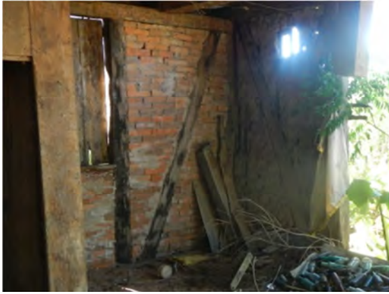
Imagem 93: Detalhe de estrutura enxaimel mista na Várzea do Agudo. Fonte: Fotografia do autor (2013).
