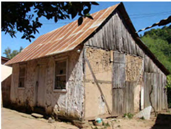
Imagem 85: Construção enxaimel propriedade Fisher, Localidade Linha Teutônia. Fonte: Inventário do Plano Ambiental (2008).
