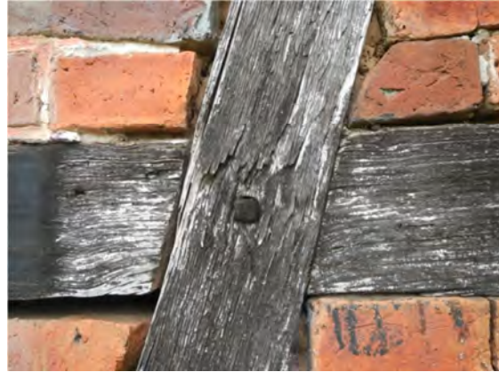
Imagem 90: Detalhe da estrutura enxaimel da propriedade da família Schiefelbein na Localidade Várzea do Agudo. Fonte: Fotografia do autor (2013).
