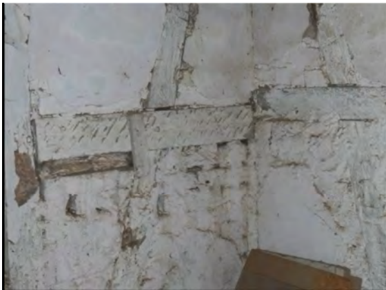
Imagem 95: Detalhe da construção enxaimel transladada e elevada para servir de depósito da propriedade Behrenz no Canto Católico. Fonte: Inventário do Plano Ambiental (2008).
