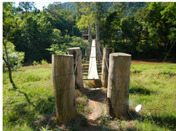
Imagem 213: Estrutura típica de uma pinguela em evidência. Fonte: Fotografia do autor (2013).
