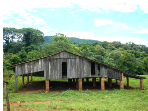
Imagem 199: Galpão de secagem de tabaco tipo Burley que cura naturalmente em contato com o ar. Fonte: Fotografia do autor (2013).
