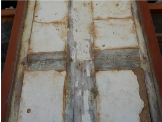
Imagem 87: Detalhe da estrutura enxaimel da propriedade da família Schiefelbein na Localidade Várzea do Agudo. Fonte: Fotografia do autor (2013).
