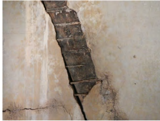
Imagem 96: Detalhe da estrutura enxaimel da propriedade da família Schiefelbein na Localidade Várzea do Agudo. Fonte: Fotografia do autor (2013).
