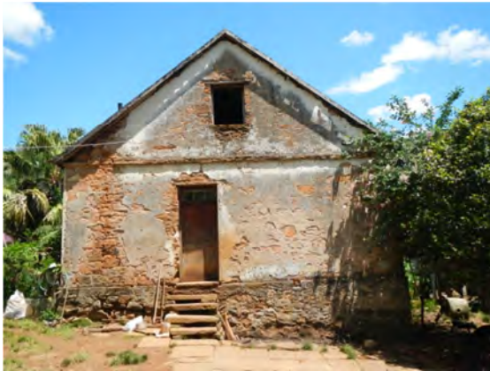
Imagem 113: Residência no interior construída integralmente com pedras arenito emparelhadas. Fonte: Fotografia do autor (2013).
