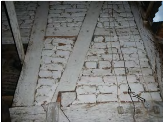
Imagem 89: Detalhe da construção enxaimel transladada e elevada para servir de depósito da propriedade Behrenz no Canto Católico. Fonte: Inventário do Plano Ambiental (2008).
