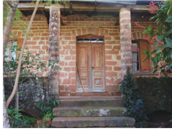
Imagem 112: Residência no interior construída integralmente com pedras arenito emparelhadas. Fonte: Fotografia do autor (2009).
