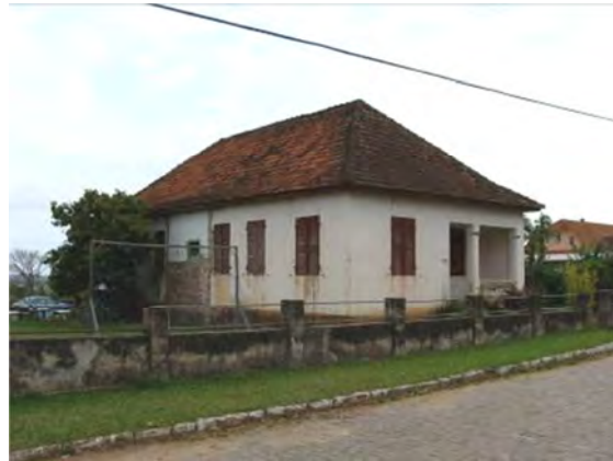
Imagem 108: Edificação da sede do município com telhado em ponto alto. Fonte: Inventário do Plano Ambiental (2009).
