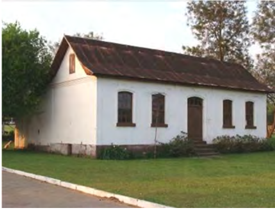
Imagem 105: Edificação característica no perímetro urbano de Agudo. Fonte: Inventário do Plano Ambiental (2009).
