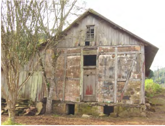
Imagem 111: Edificação com estrutura enxaimel completada por pedras grés no interior de Agudo. Fonte: Fotografia do autor (2009).
