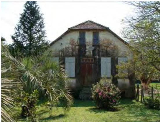
Imagem 107: Edificação no interior que apresenta o telhado com tacaniça. Fonte: Inventário do Plano Ambiental (2009).
