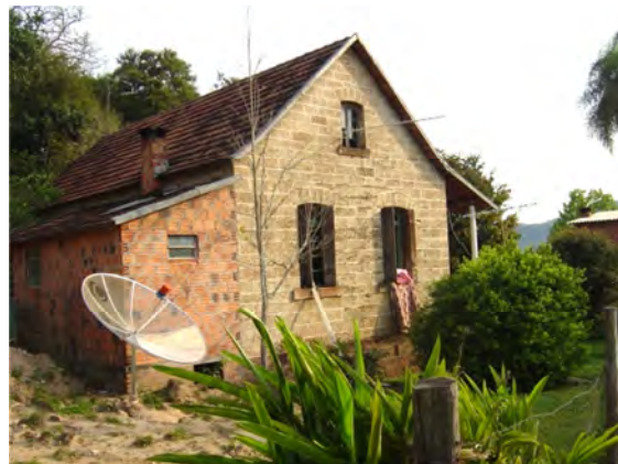
Imagem 229: Contraste entre casa de pedra, seu novo anexo e a antena. Fonte: Fotografia do autor (2013).
