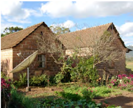
Imagem 230: Residência típica no interior com antena parabólica descaracterizando seu volume original. Fonte: Fotografia do autor (2009).
