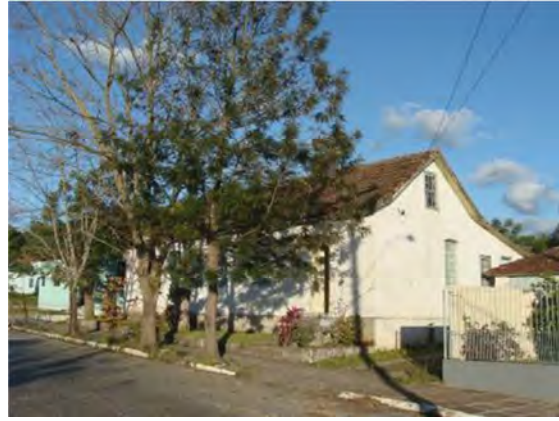
Imagem 106: Edificação típica onde se nota a mudança de inclinação junto à parte traseira. Fonte: Inventário do Plano Ambiental (2009).
