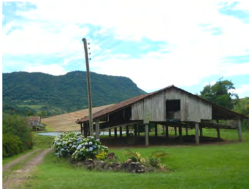
Imagem 198: Galpão de secagem de tabaco tipo Burley , que dispensa a necessidade de estufa aquecida. Fonte: Fotografia do autor (2013).
