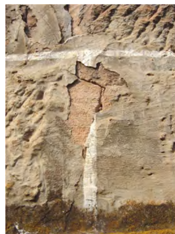
Imagem 116: Detalhe da técnica de recobrimento e posterior pintura imitando ou recompondo os rejundes entre os blocos de pedra grés. Fonte: Fotografia do autor (2009).
