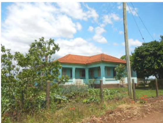
Imagem 224: Residência reformada no interior de Agudo. Fonte: Fotografia do autor (2013).
