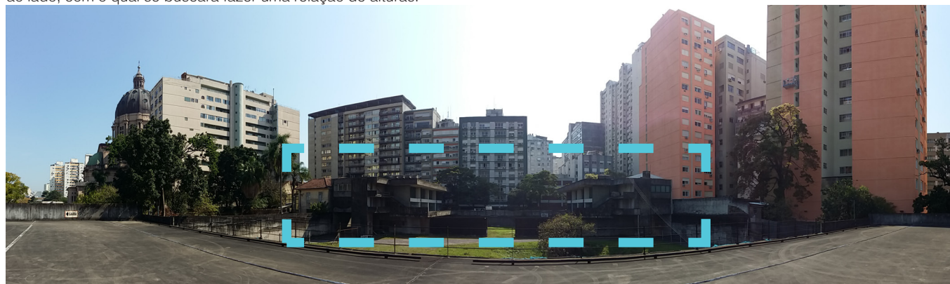
*foto panorâmica tirada do último pavimento do estacionamento do Zaffari da Fernando Machado em direção a rua Duque de Caxias. Pode-se observar o gabarito do entorno, com edificações altas, característica que buscará ser seguida no projeto.
