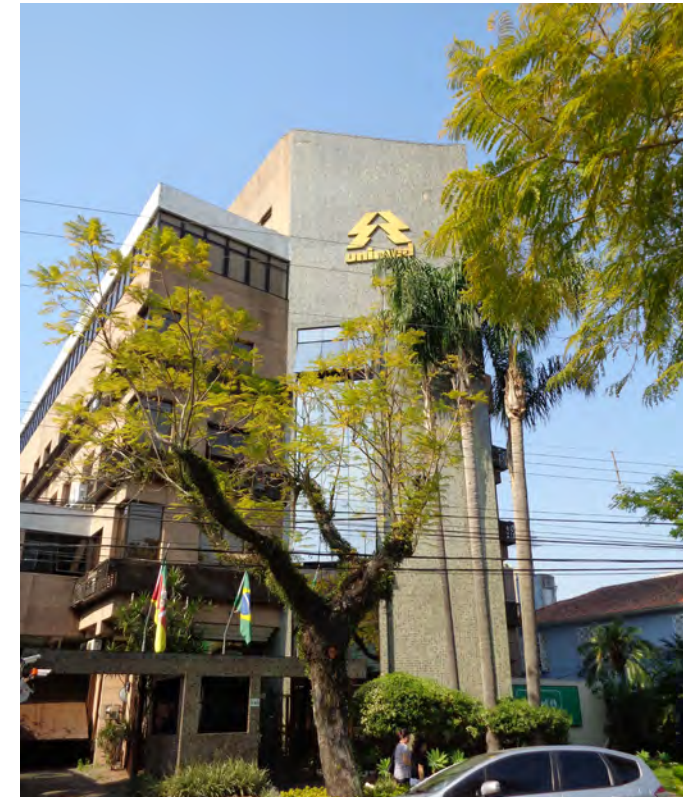
Edifício comercial pertencente à Unimed, na rua Santa Terezinha
