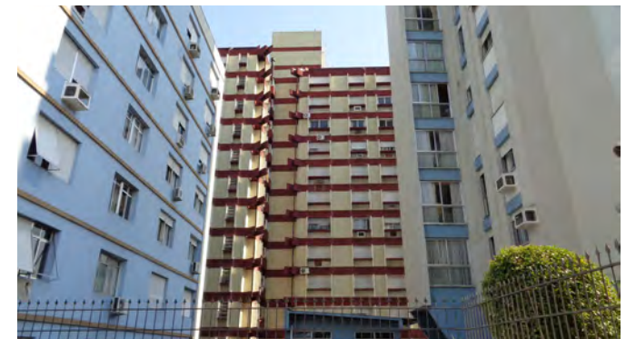
Edifícios residenciais na Rua Vieira de Castro, próximo à Avenida Jerônimo de Ornelas
