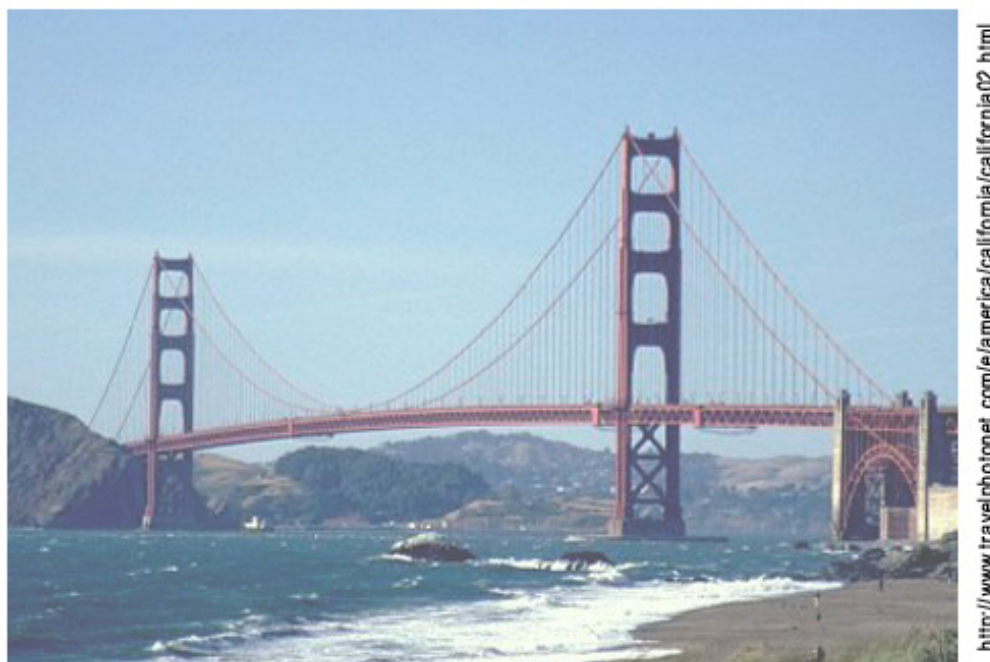
Figura 13 – A ponte “Golden Gate”. A distância entre as pilastras é de 1280 metros.
