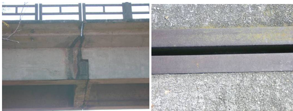
Figura 12 – Pequeno espaço deixado entre os blocos de concreto de uma ponte, devido à dilatação térmica.
