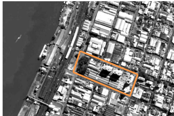
Figura 66: "Terreno". Acima: terreno da Fiateci e Vonpar (Fonte: Fernandes, 2014, p. 135); Abaixo: Imagem de satélite que mostra a implantação das torres do mix residencial Rossi Fiateci.
