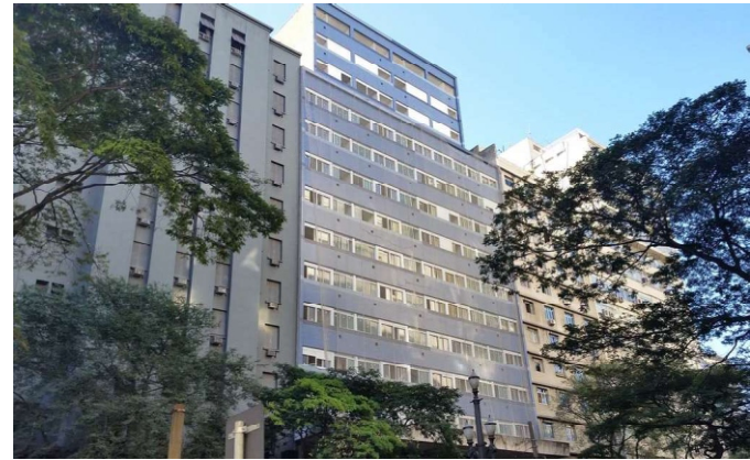
Figura 21 – Avenida Ipiranga: Fachada Principal reformada
