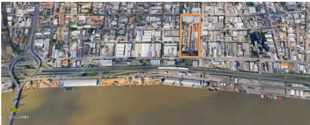
Figura 65: Ideal (?) x real. Acima: Imagem elaborada pela Ronaldo Rezende Arquitetura (fonte: https://revista.zapimoveis.com.br/patrimonio-arquitetonico-conta-a-historia-do-4-districto-de-porto-alegre-3310052-sc/ ); Abaixo: Realidade do local (Fonte: Imagem do google earth)
