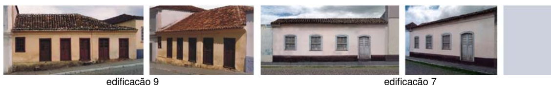
Figura 5.31: Edificações coloniais familiares para respondentes das cidades de Piratini e Pelotas
