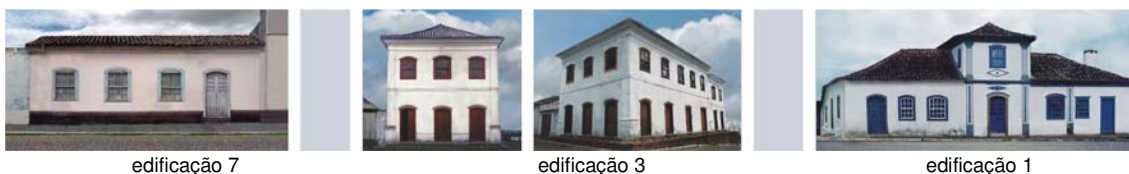
Figura 5.14: Edificações coloniais consideradas antigas
