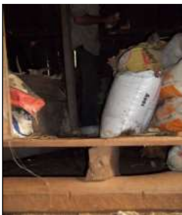
Figura 36 - Espaço abaixo do galpão para permitir a circulação de ar e dos gatos
