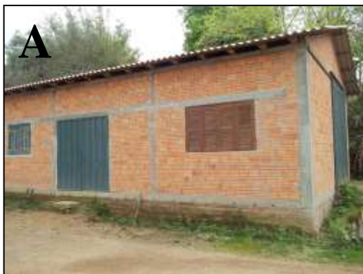
Figura 37 - Exemplos de tipos de galpão em Ibarama (A) e em Tenente Portela (B)
