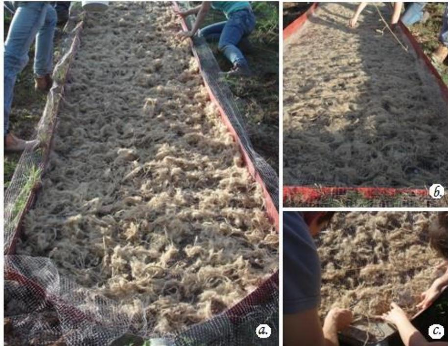
**Figura 13** – Instalação da biomanta de Sisal.
