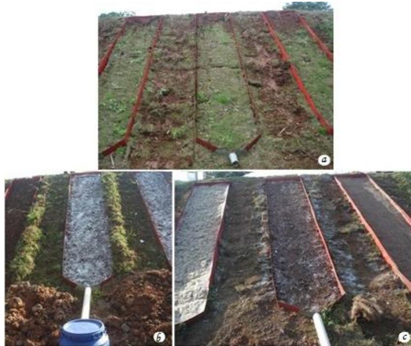
**Figura 7** – Preparo do solo e instalação dos sistemas.
