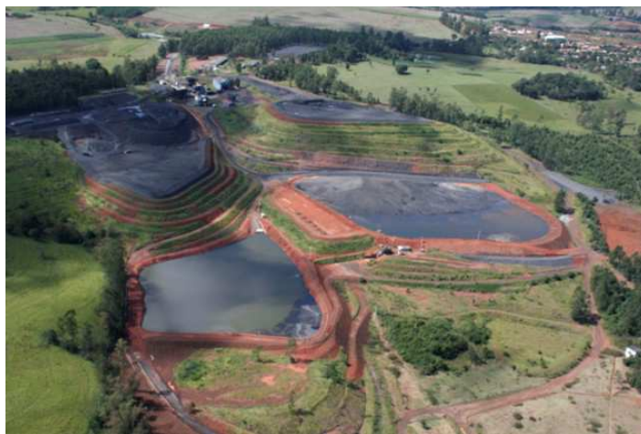
Figura 2. Módulo de rejeitos de carvão e bacia de contenção da DAM, Município de Figueira (PR) (Carbonífera do Cambuí LTDA, 2008).
