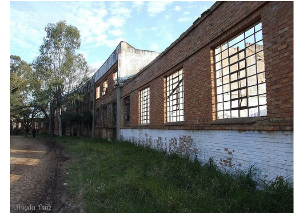
Fig.8:Edificação existente a ser demolida.
