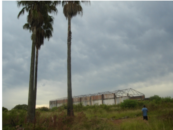
Fig.7:Galpão 1 a ser reformado.
