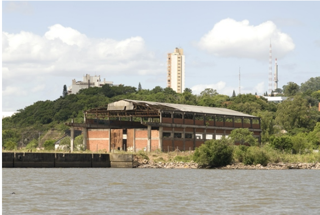
Fig.6:Galpão 2 a ser reformado.
