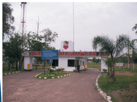
1. Acesso ao Clube pela Br116 atual portaria e administração
