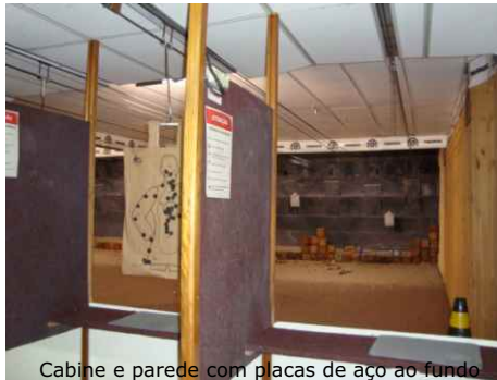
Cabine e parede com placas de aço ao fundo
