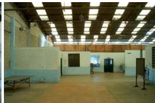
Foto 13 - Hall da área esportiva com sala de professores ao fundo
