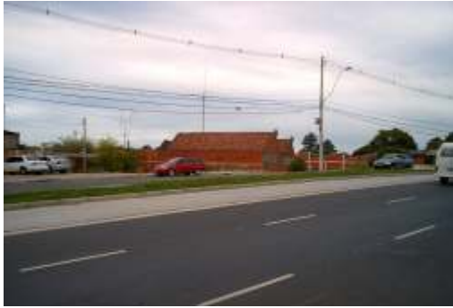
Foto 1 - Vista a partir da Av. Baltazar de O. Garcia, sentido centro-bairro
