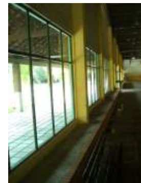
Foto 30 - Esquadrias centro de eventos
