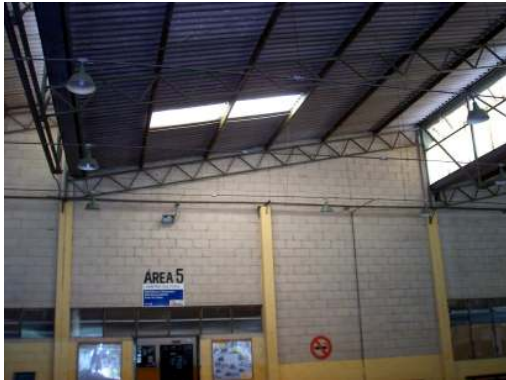
Foto 20 - Detalhe da estrutura modular e cobertura em sheds com estrutura metálica
