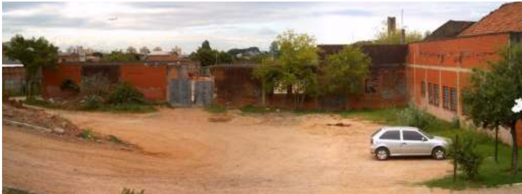
Foto 5 - Panorâmica do acesso, ao fundo antigo pavilhão em péssimo estado de conservação.
