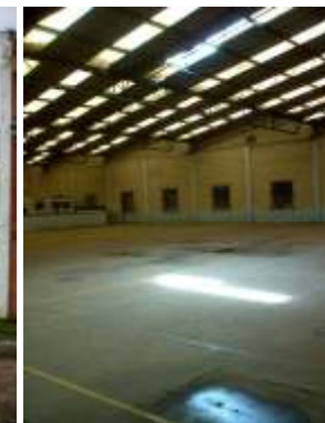
Foto 10 - Quadra coberta de concreto
