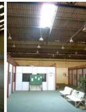
Foto 11 - Hall da área de atendimento social, salas configuradas por divisórias
