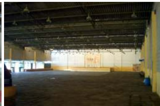
Foto 17 - Centro de Eventos, com palco ao fundo
