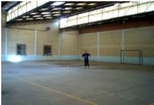
Foto 24 - Quadra indoor com piso em cimento
