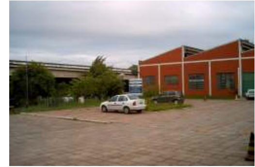
Foto 4 - Área de estacionamento e acesso aos prédios
