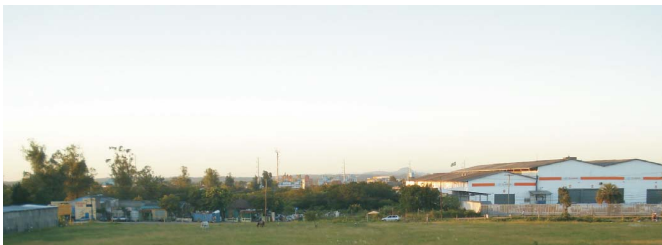
Foto 06 - AV FRANCISCO SILVEIRA BITENCOURT Atualmente ao longo dessa avenida estão localizados pavilhões de pequenas e grandes industrias caracterizados por possuírem no máximo dois pavimentos
