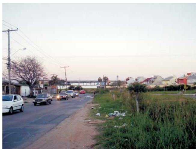
Foto 08 - AV FRANCISCO SILVEIRA BITENCOURT Perfil viário de atual de 15,00m e previsão de ampliação para 47,00m
