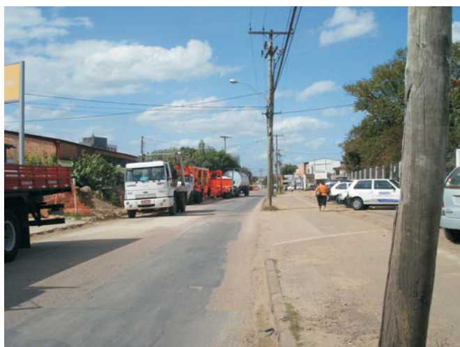
Foto 01 - R SENHOR DO BOM FIM Perfil viário de 22,00m
