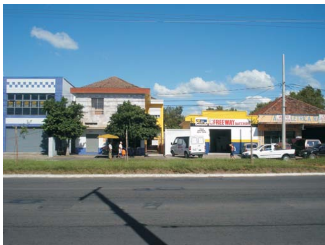
Foto 04 - AV ASSIS BRASIL Perfil viário de 47,00m
