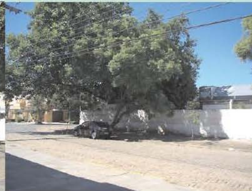
5. fachada av. Maranhão
