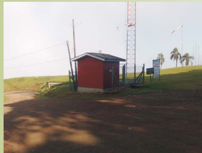
Foto 5 (casa de força)
