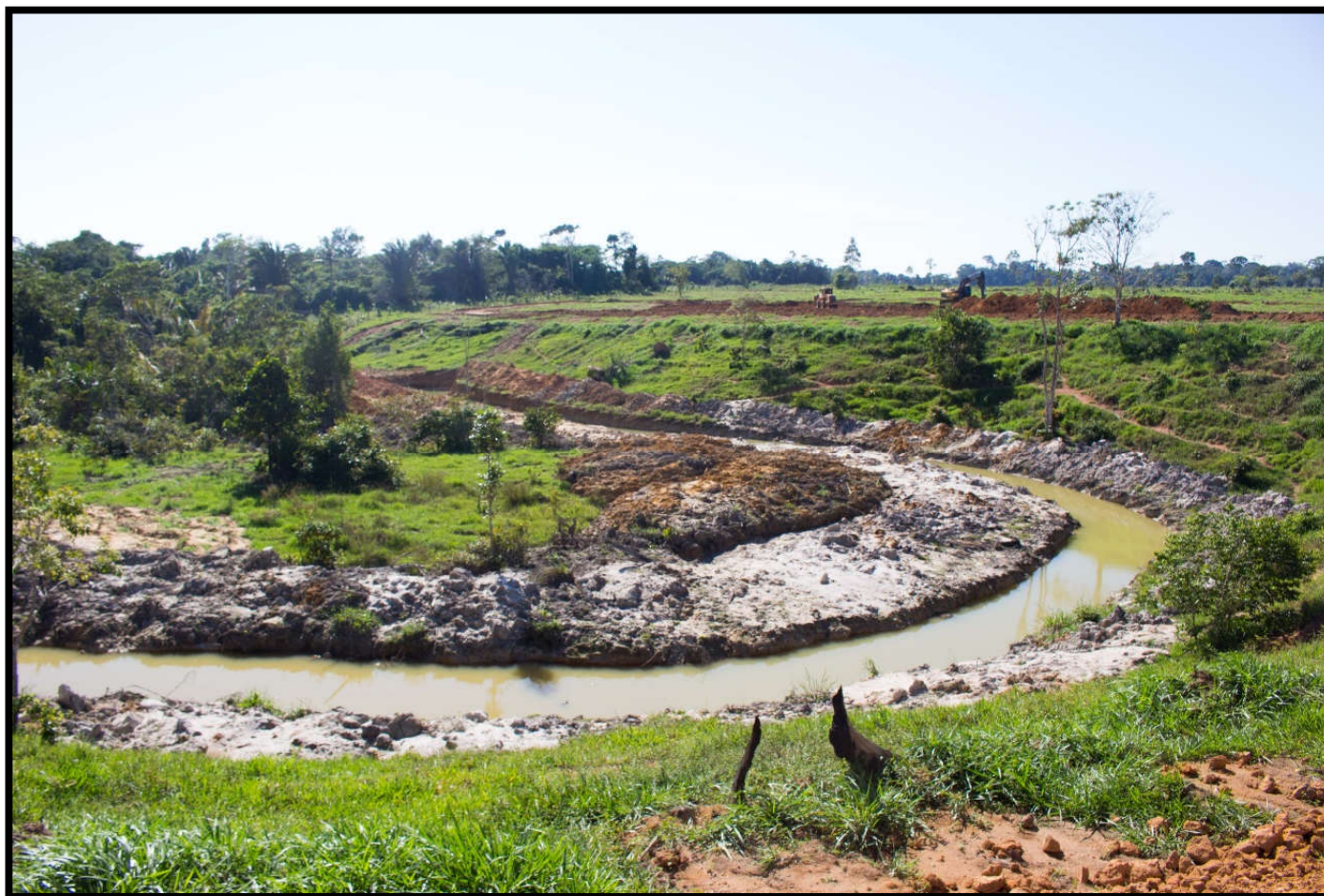
Foto 16 – Canal de desvio de água para abastecimento de piscicultura de grande porte em Ariquemes, RO.
