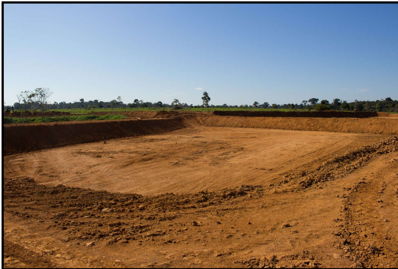
Foto 18 - Tanque escavado para piscicultura, ainda seco, em propriedade de grande porte na cidade de Ariquemes, RO.
