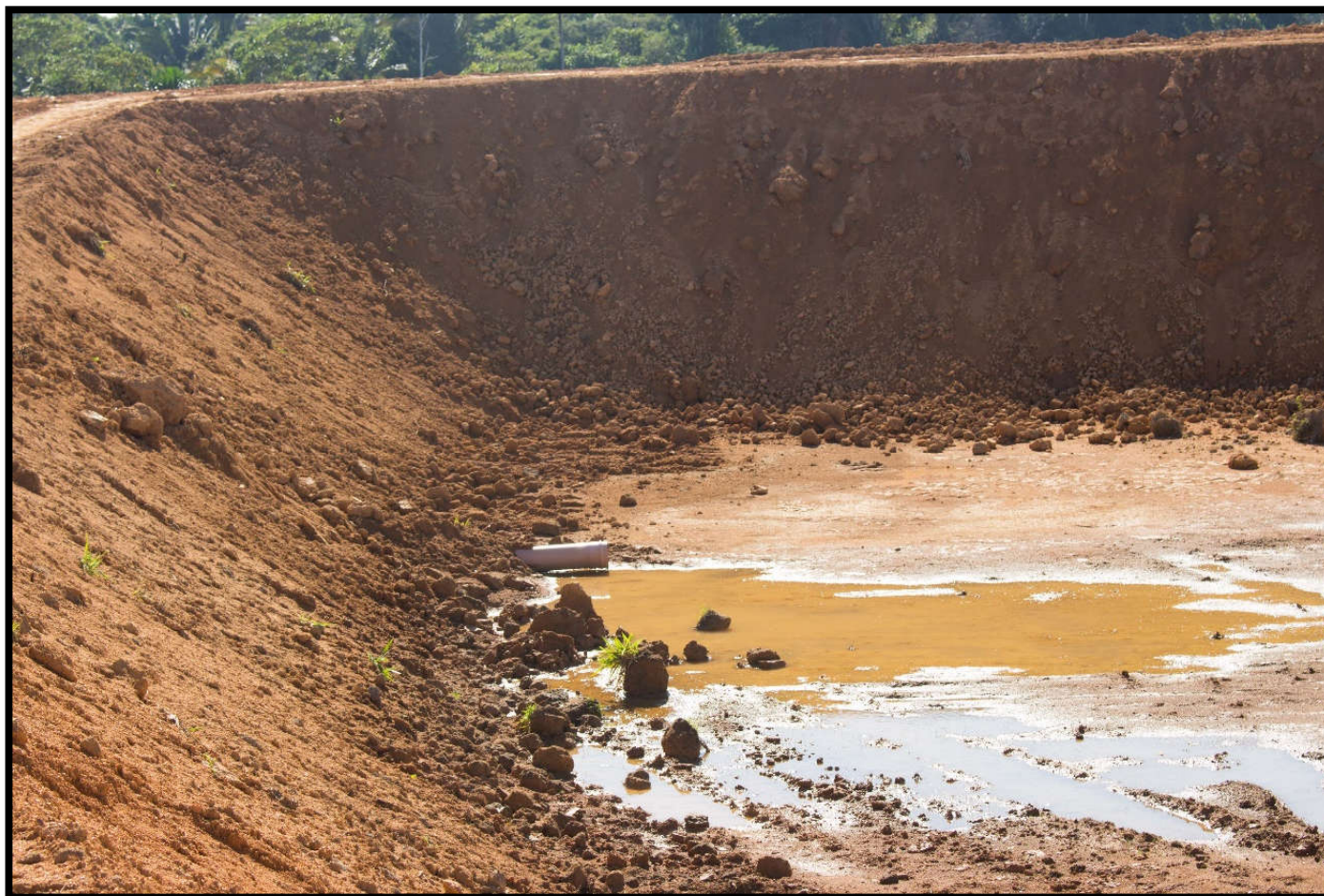
Foto 17 - Tanque escavado para piscicultura, ainda seco, em propriedade de grande porte na cidade de Ariquemes, RO.
