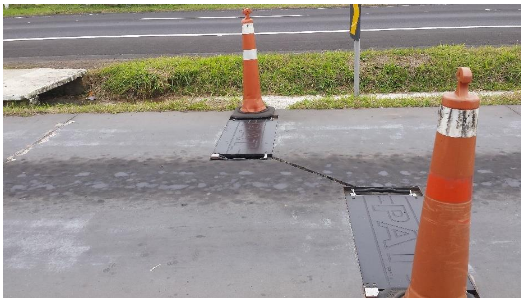
Figura 4.2 – Conjunto de balanças para medição de pesos em movimento no PPV de Gravataí, RS (em defasagem para medição de velocidade).
