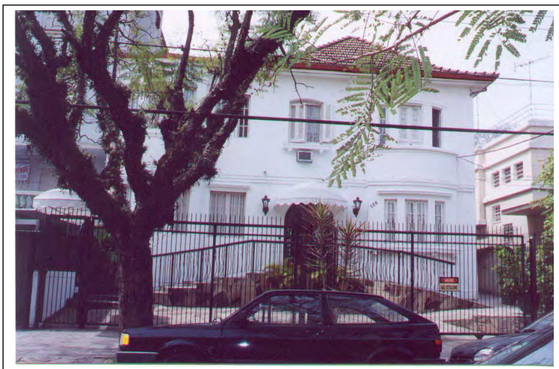
FIGURA 174: Fachada da geriatria Bom – Fim, Santa Terezinha, Santana, Porto Alegre. Fonte: registro da autora.
