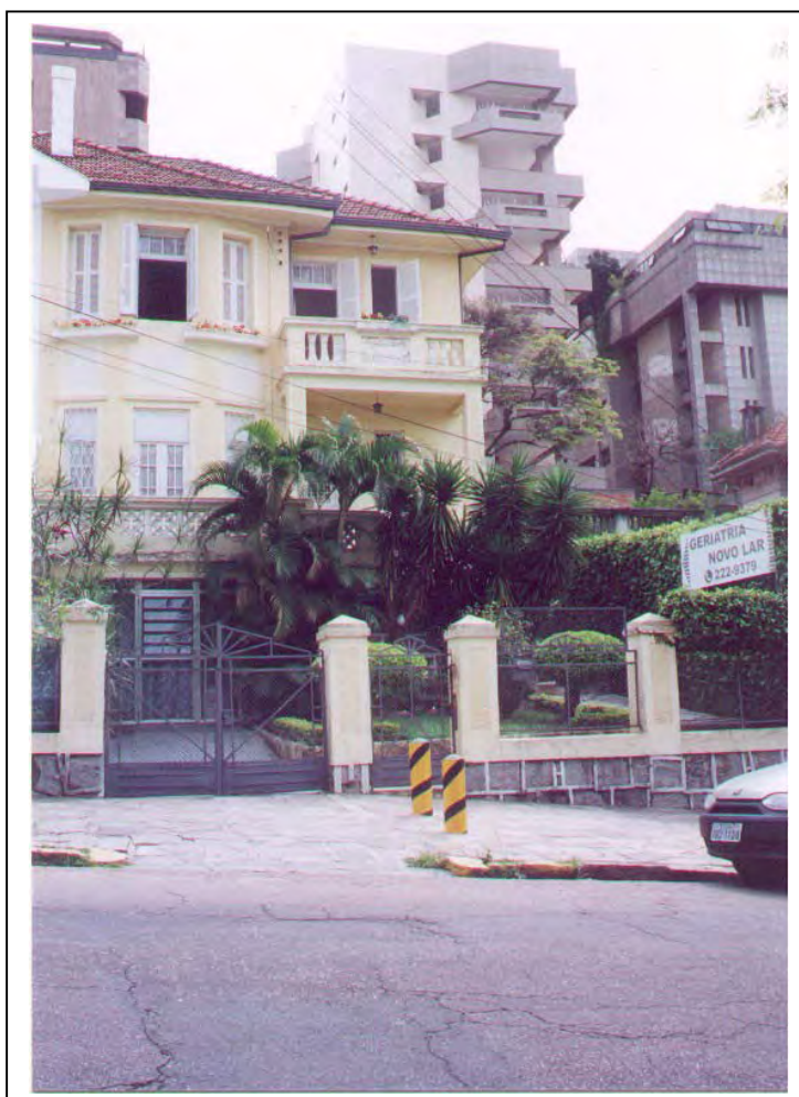
FIGURA 183: Fachada do Residencial Geriátrico Novo Lar I, localizado na rua Barão Santo Ângelo, Moinhos de Vento, Porto Alegre. Fonte: registro da autora
