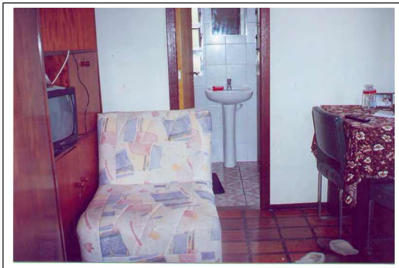
FIGURA 207: Apartamento B. Observe-se a largura inadequada do acesso ao banheiro e a presença de um móvel dificultando a passagem. Residencial Pedra Redonda, Cel. Marcos, Pedra Redonda, Porto Alegre. Fonte: registro da autora.
