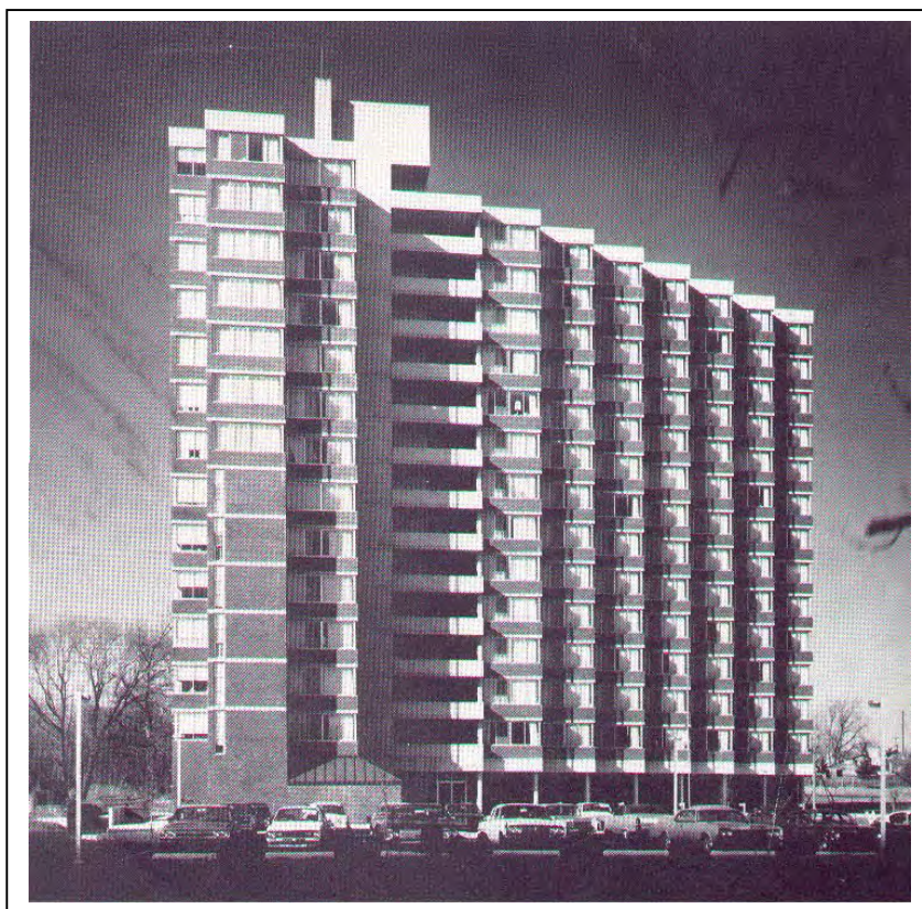
FIGURA 74: Fachada principal do Grundy Tower, na cidade de Bristol, Pennsylvania, projetado por Louis Sauer associates & associated architect Frank Schlesinger. Fonte: HOYT, 1977.
