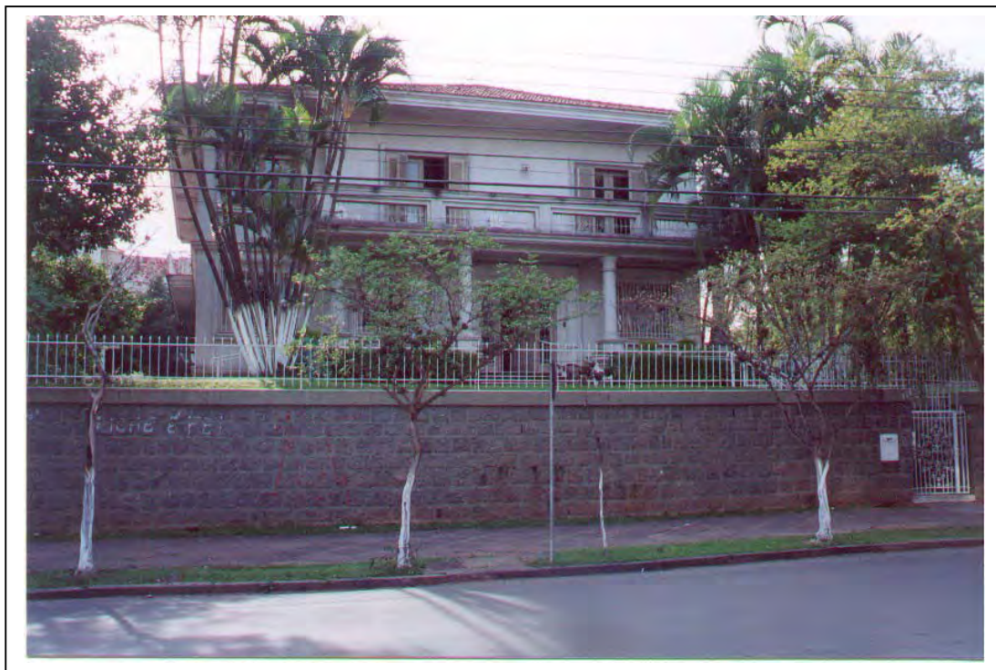
FIGURA 160: Fachada da clínica geriátrica Bella Vista. Comendador Pedro Chaves Barcellos, Boa Vista, Porto Alegre. Fonte: registro da autora.
