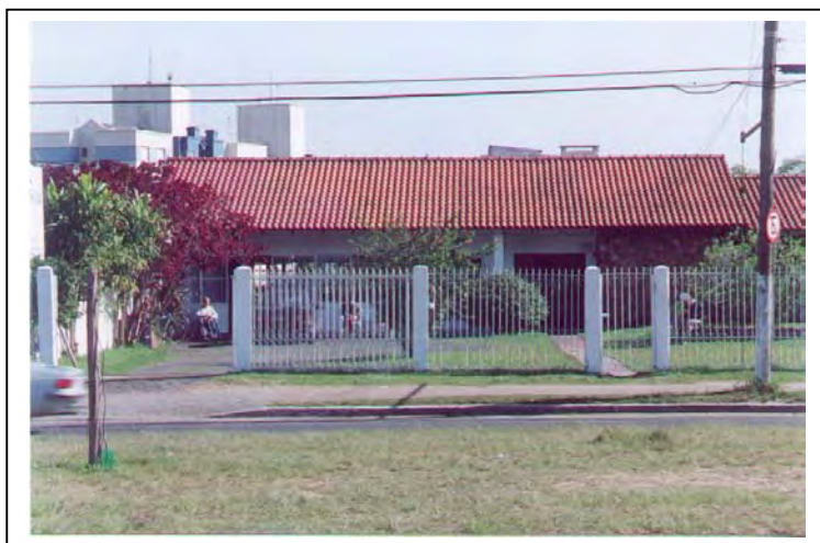
FIGURAS: Fachada (161) e vista do pátio externo (162) da clínica geriátrica Santa Catarina. Protásio Alves, Chácara das Pedras, Porto Alegre. Fonte: registro da autora.
