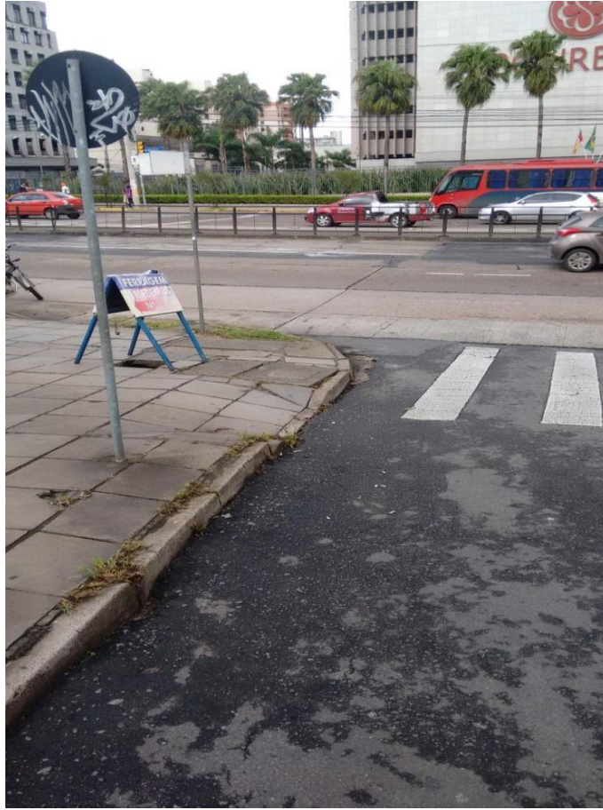
Figura 17 - Esquina Rua Edmundo Bastian
