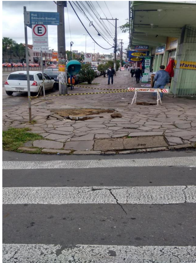
Figura 18 - Esquina Rua Edmundo Bastian
