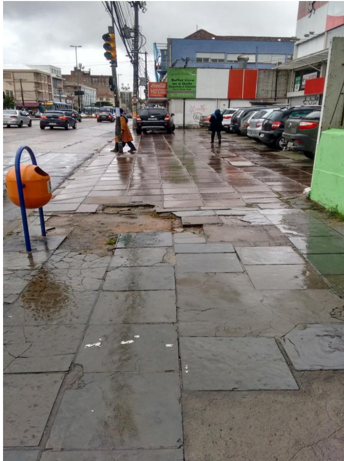
Figura 30 - Esquina Rua Bernardi 1
