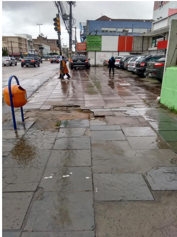
Figura 30 - Esquina Rua Bernardi
