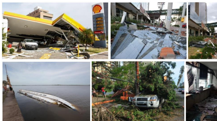
Figura 18 – Exemplos de danos causados durante o downburst de Porto Alegre
