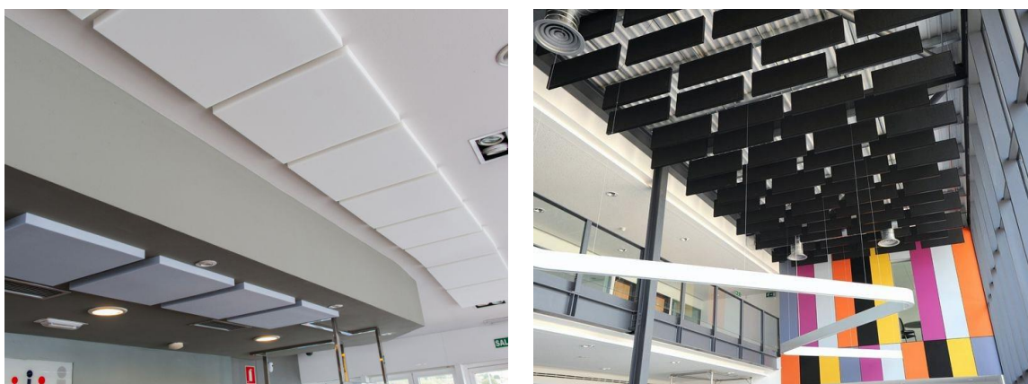
Figura 6.34 Ejemplos de paneles absorbentes que pueden llegar a instalarse en una planta industrial de un proveedor particular, se muestran dos posibles formas de instalación. (Fuente: Isoltop)
