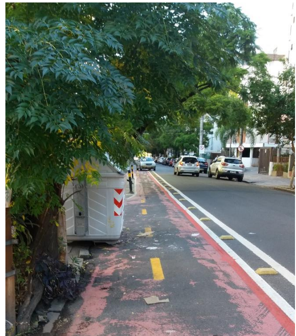
Figura 88 – Container de lixo na faixa
