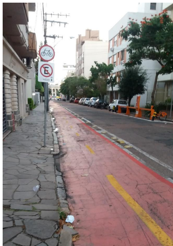
Figura 78 – Sinalização horizontal e vertical em boas condições
