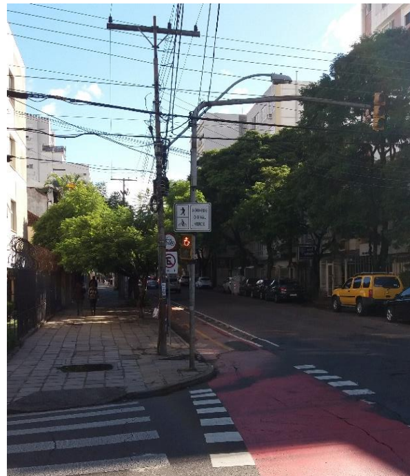
Figura 46 – Iluminação na saída da interseção
