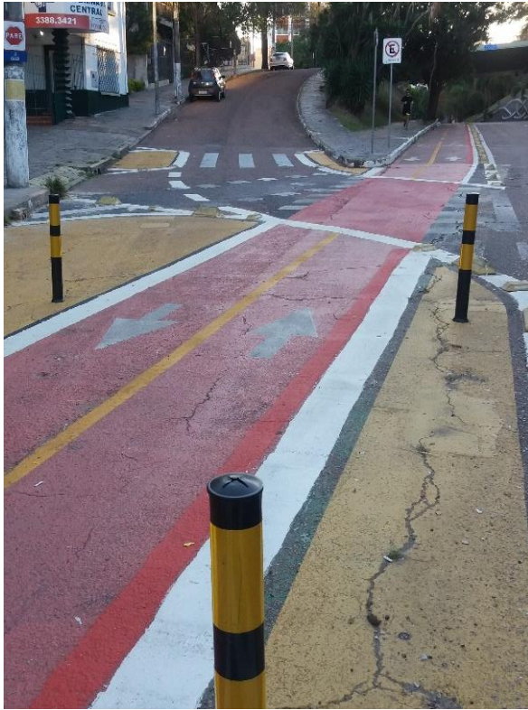
Figura 40 – Interseção devidamente sinalizada
