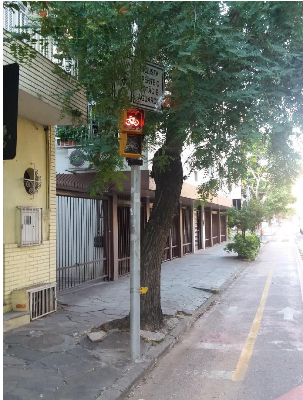
Figura 30 – Vegetação prejudicando a visibilidade da placa de sinalização
