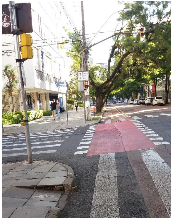
Figura 50 – Identificação da interseção com leve desnível no pavimento
