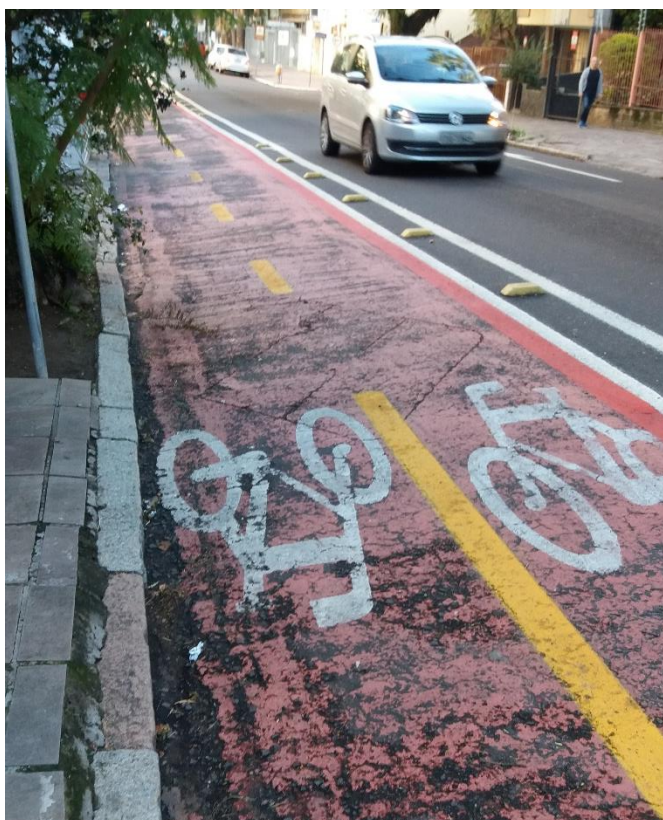
Figura 84 – Desnível da ciclofaixa em relação a pista
