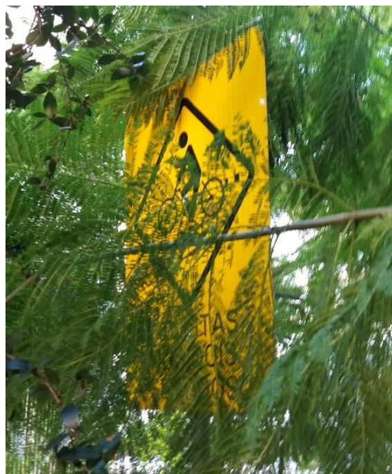
Figura 57 – Placa de sinalização coberta por vegetação
