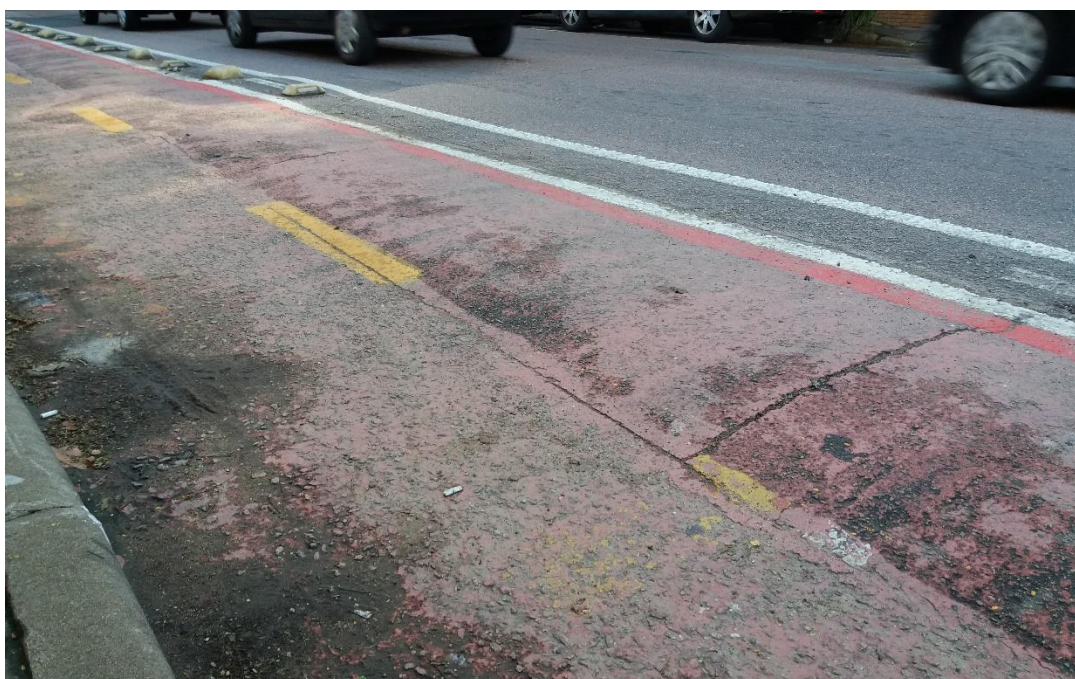
Figura 47 – Desnível presente em todo o eixo longitudinal
