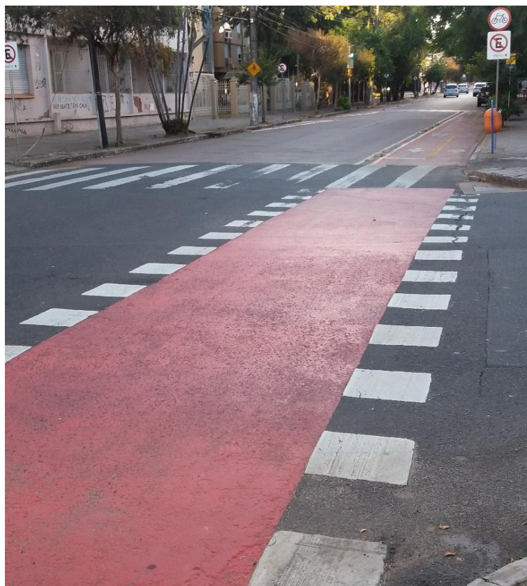
Figura 21 – Interseção 1 apresentando ótimas condições do pavimento e sinalização
