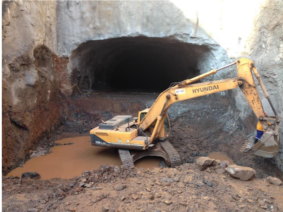
Figura 10 – Escavação na entrada do túnel de desvio do rio
