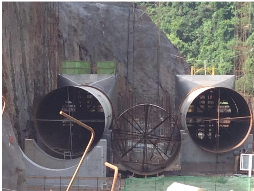
Figura 24 – Montagem dos condutos fechados
