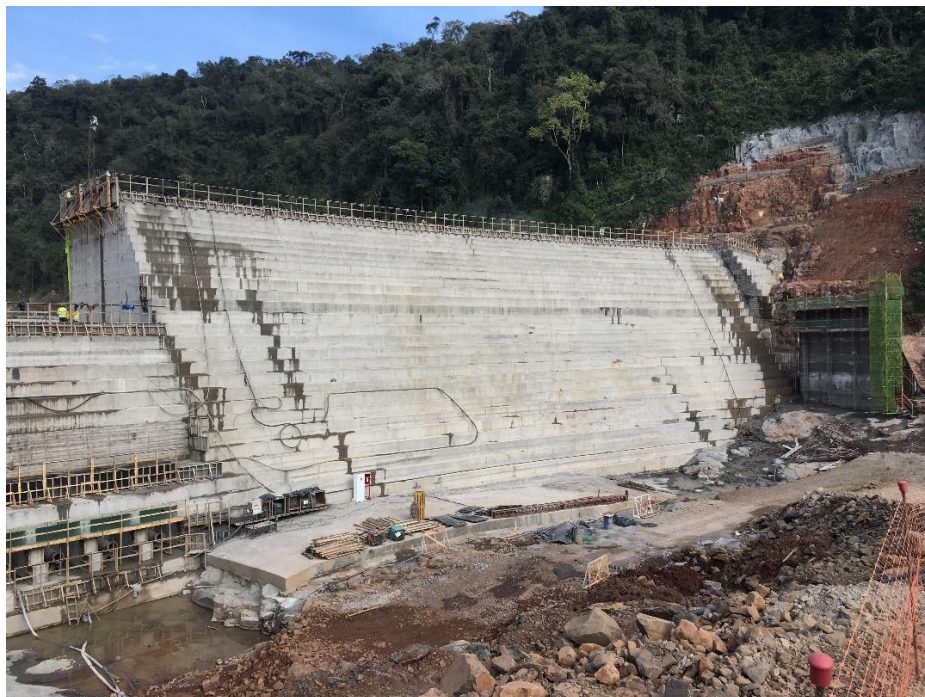
Figura 20 – Barragem em fase de construção
