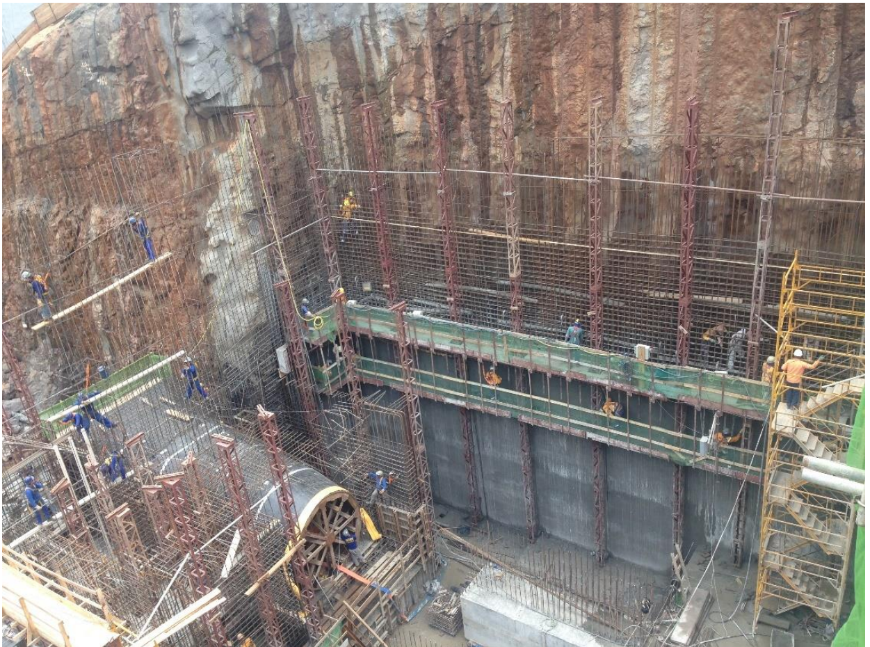
Figura 18 – Casa de Força em construção fase inicial
