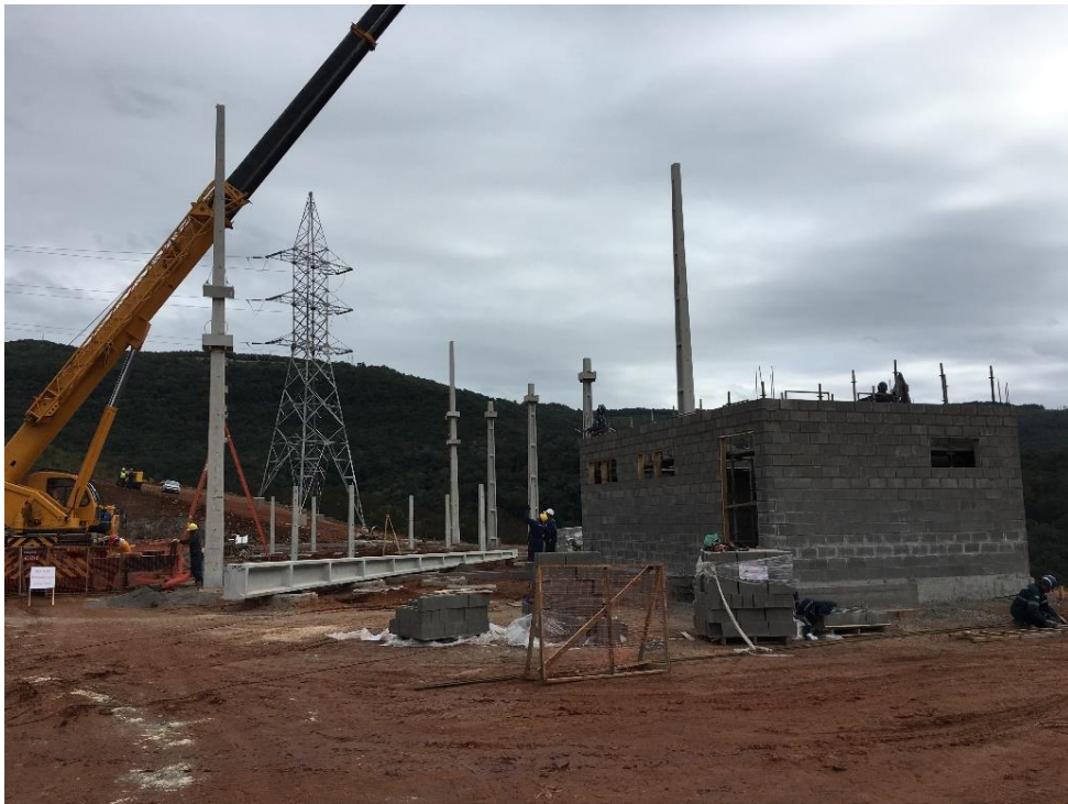
Figura 21 – Subestação em fase de construção
