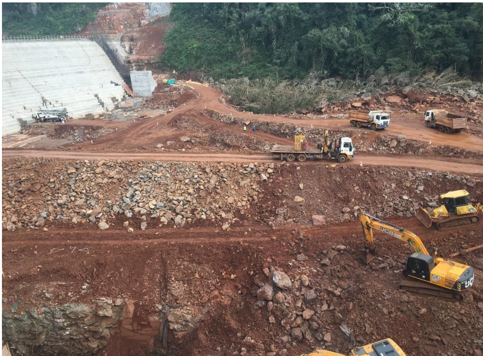
Figura 7 – Regularização de acessos pela equipe de Terraplanagem
