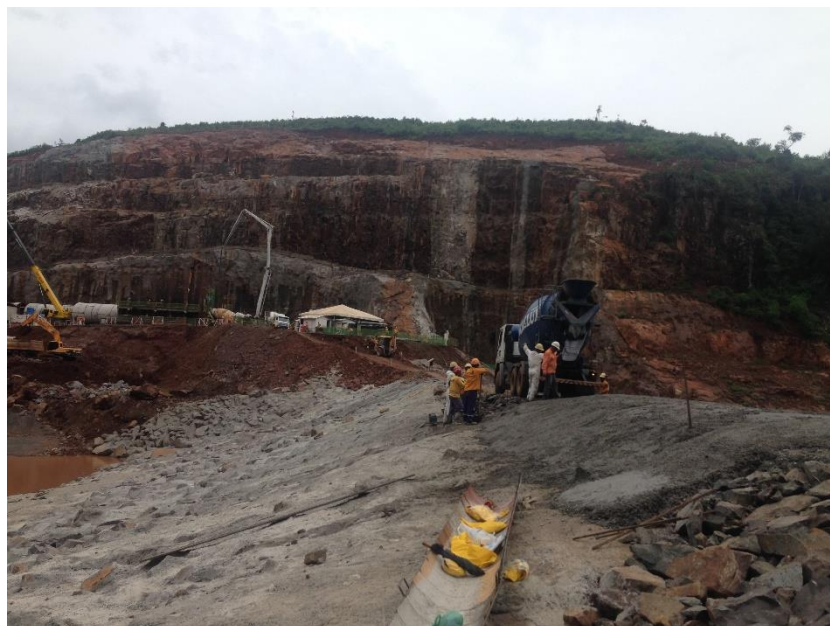
Figura 11 – Talude de ensecadeira tratado com concreto
