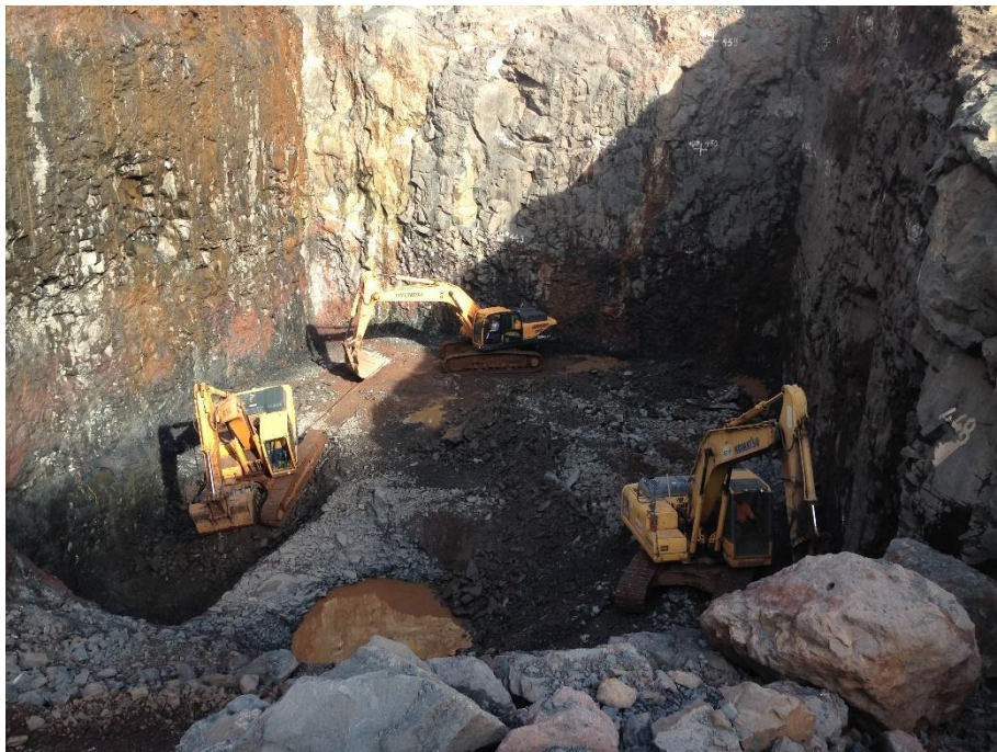
Figura 9 – Escavação em rocha para abertura do espaço para Casa de Força
