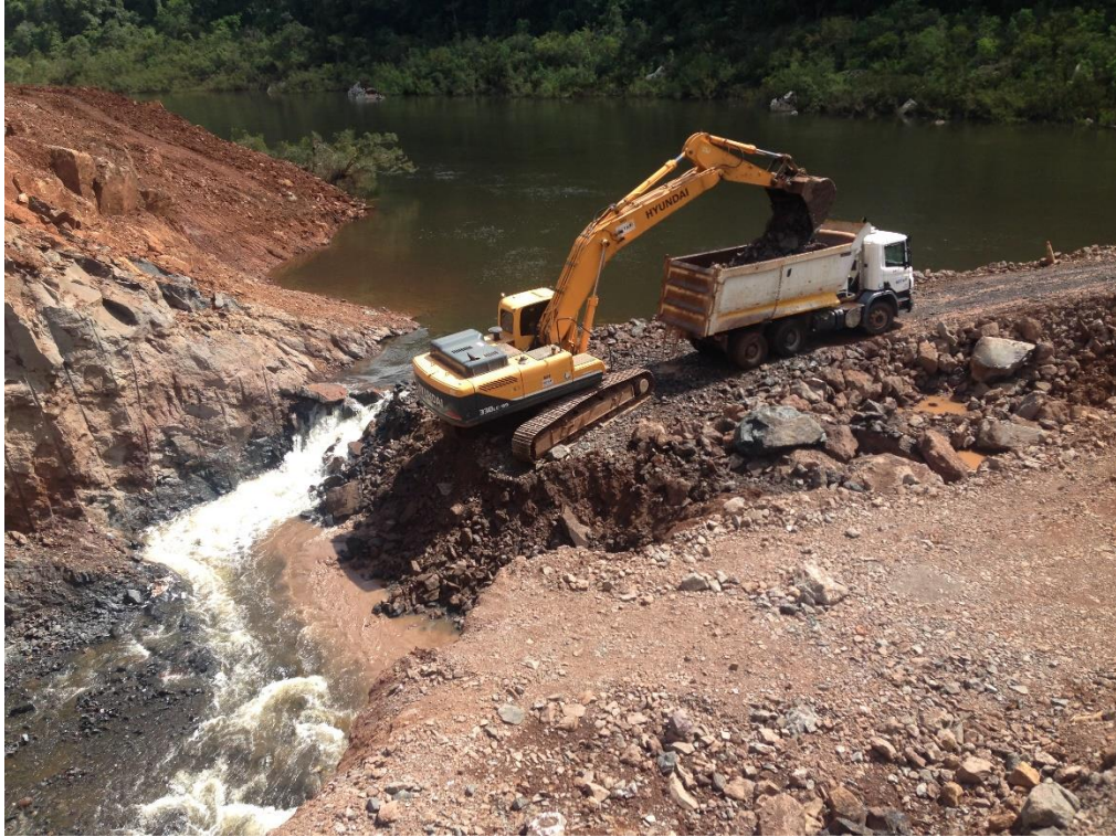
Figura 8 – Construção de ensecadeira
