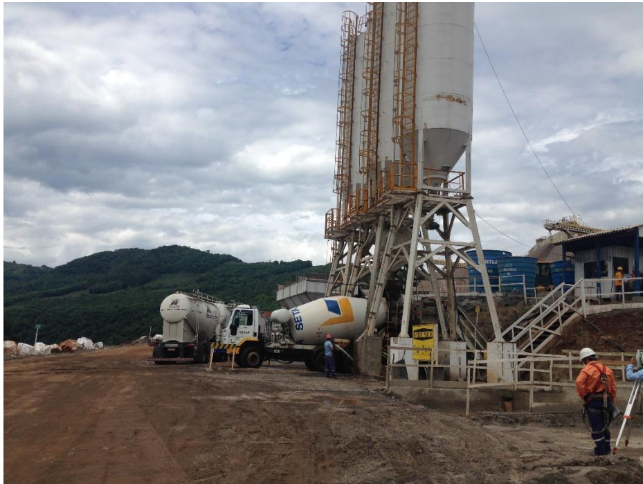
Figura 13 – Caminhão betoneira sendo carregado de concreto
