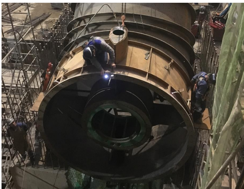
Figura 15 – Atividade de solda do conduto fechado
