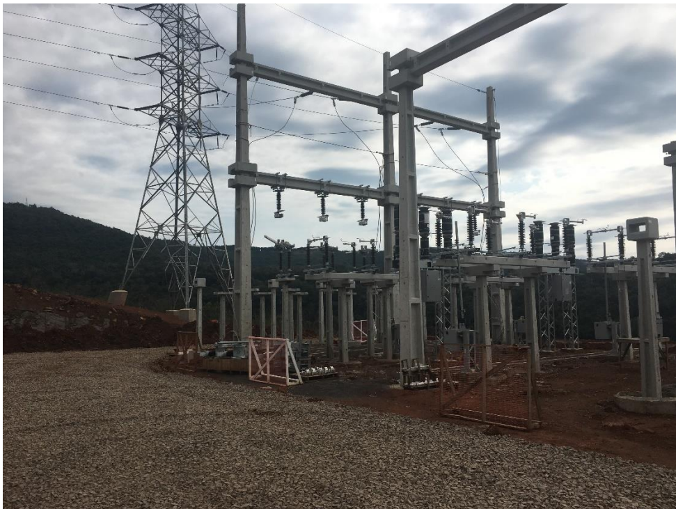
Figura 22 – Subestação em fase de construção
