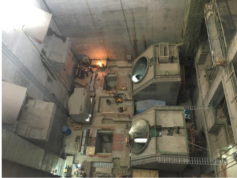
Figura 19 – Casa de Força em construção fase média de projeto
