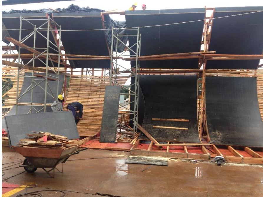
Figura 14 – Formas de madeira moldes da barragem
