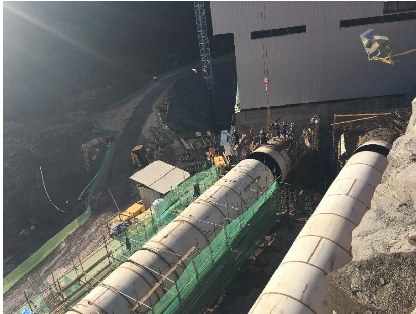
Figura 23 – Montagem dos condutos fechados
