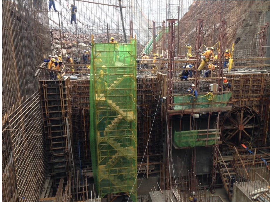
Figura 16 – Armação da ferragem na Casa de Força
