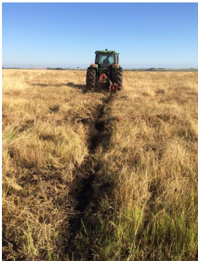
Figura 3- Drenagem de área já preparada e previamente dessecada.
