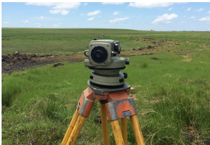
Figura 8 – Demarcação de valo condutor.
