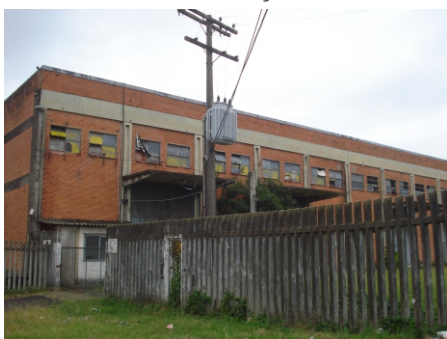
Edificação esq. R. F. Mentz e J. C. de Azevedo
