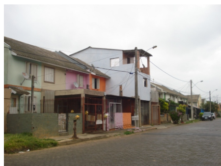
Edificações na J. C. de Azevedo
