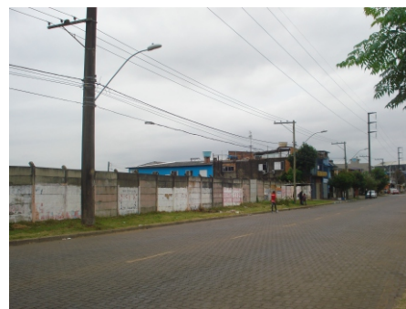
Muro do lote e edificações na R. F. Mentz
