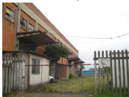
Entrada do terreno pela R. J. C. de Azevedo
