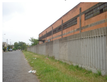
Lateral da edificação na R. J. C. de Azevedo
