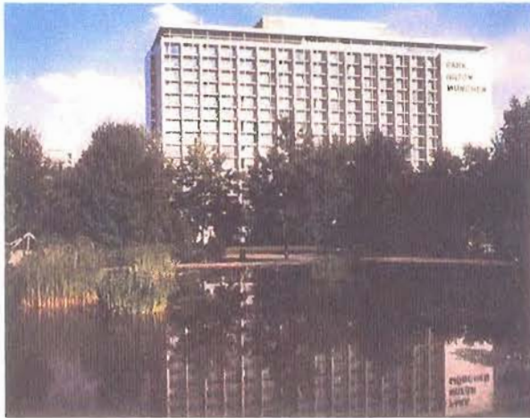
Figura 14- Munich Park Hilton Hotel, Alemanha (BRECSU, sep.1995).
