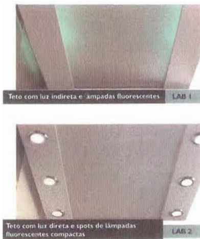
Figura 105- Exemplo de tetos com iluminação indireta e lâmpadas fluorescentes; e teto com luz direta e spots de lâmpadas fluorescentes compactas (Schindler, Catálogo, 1998).
