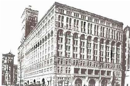
Figura 13 - Edifício Auditorium, Chicago, EUA. Projeto de Adler & Sullivan. (PEVSNER, 1980, p. 223.)
