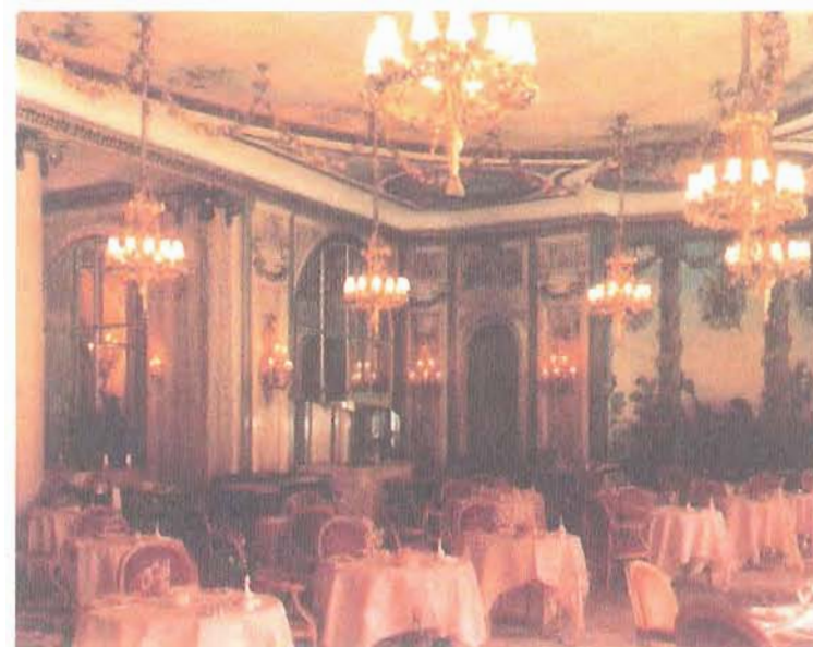
Figura 12 - O novo equipamento de resfriamento se mistura à decoração interior no famoso restaurante do Ritz Hotel Piccadilly, Londres (BRECSU, oct.1994).
