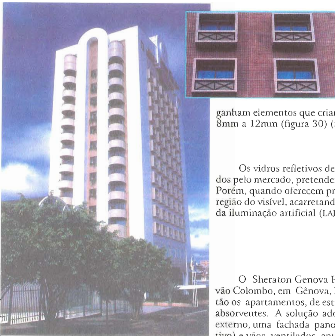
Figura 30 - Plaza Inn Master, Uberlândia, MG. Elementos de sombra combinados ao uso do vidro e da cor. (SOLUÇÕES, 1997, p.76)
