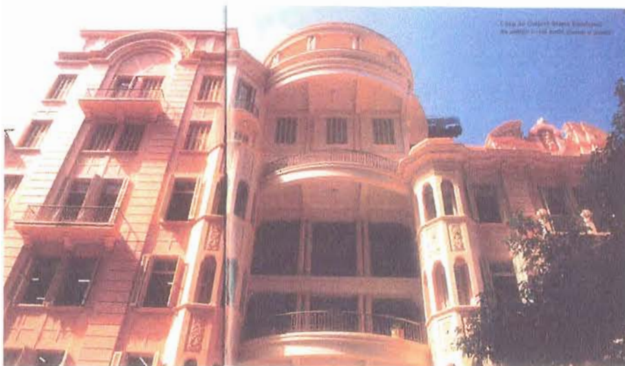
Figura 63 -Casa de Cultura Mario Quintana., Porto Alegre, Brasil. Vista externa 1990 (MAIELLO, 1996, p.45).
