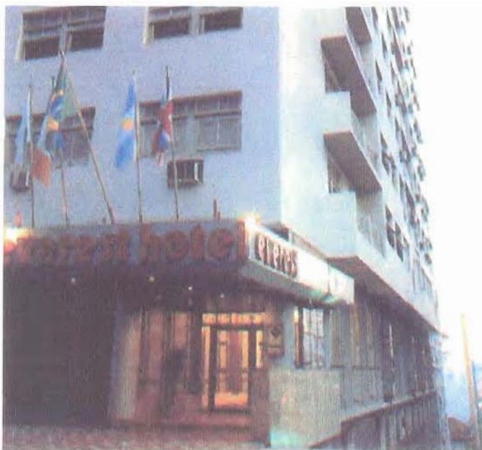
Figura 16 - Vista da fachada principal do Hotel H.
