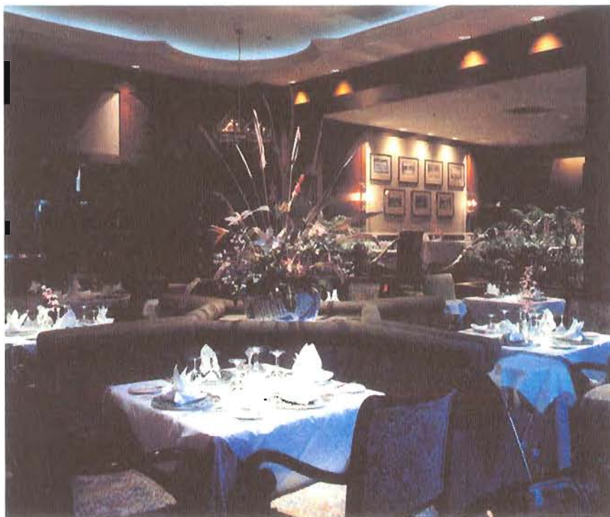
Figura 116 - Orlando World Center, Flórida, EUA. Sistema de iluminação combinado: luminárias dowlights com foco direcionado aos quadros na parede- iluminação de destaque com focos verticais sobre as mesas de jantar, além do forro com iluminação indireta (SAITO, 1988, p. 195).
