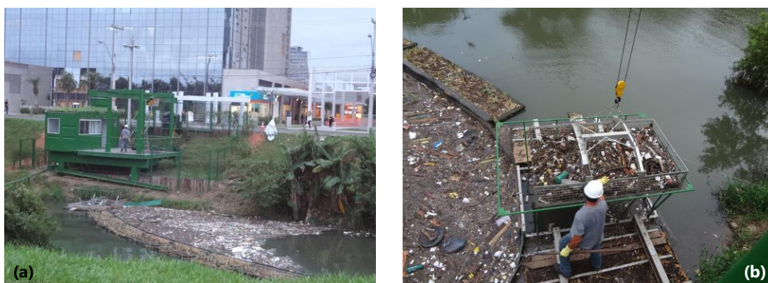
Figura 5.30 – Fotos da Ecobarreira de resíduos sólidos instalada no Arroio Dilúvio.
