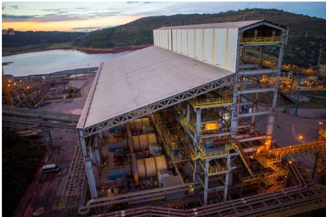
Figura 14 – Prédio da Moagem – Usina de Conceição 2 – Itabira
